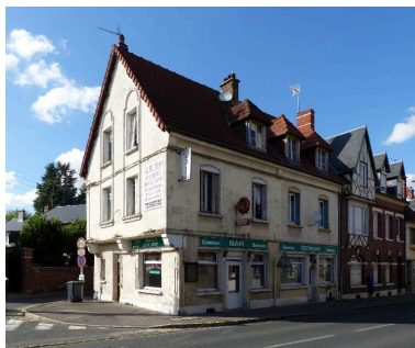
Vue générale, depuis la rue Saint-Fursy. Phot. Isabelle Barbedor IVR32_20178005238NUCA
