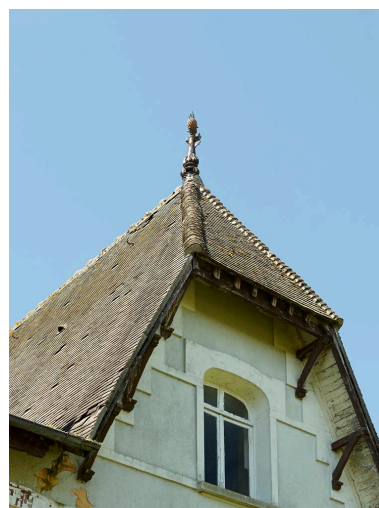
Détail de la croupette arrière et de l'épi de faîtage en forme d'ananas. Phot. Delphine Volto-Jourdan IVR32_20216200622NUCA
