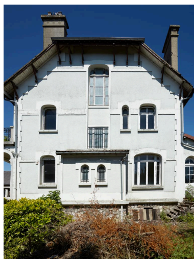
Vue de la façade latérale droite. Phot. Delphine Volto-Jourdan IVR32_20216200619NUCA
