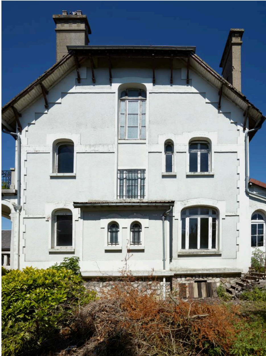
Vue de la façade latérale droite.
