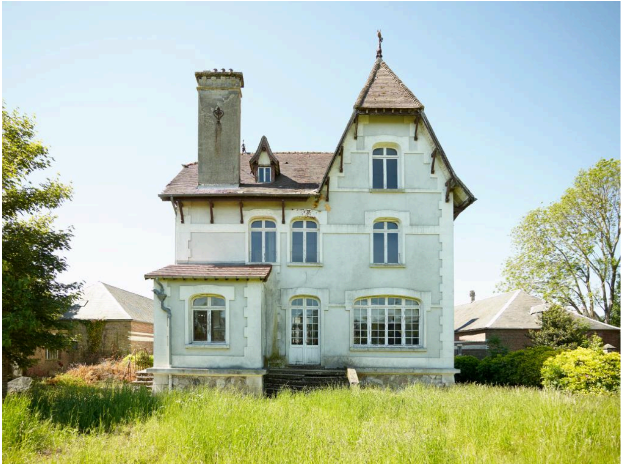
Vue de la façade arrière.
