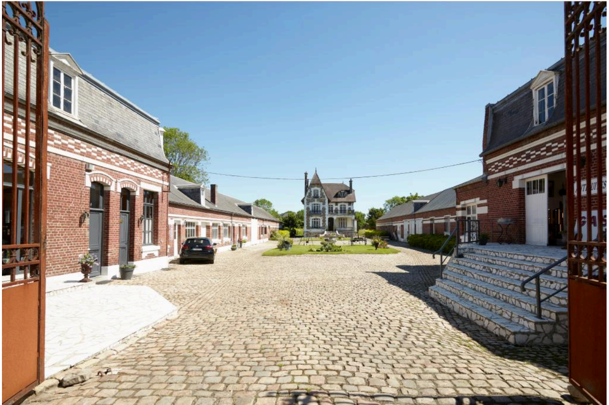
Vue générale depuis l'entrée de la cour.
