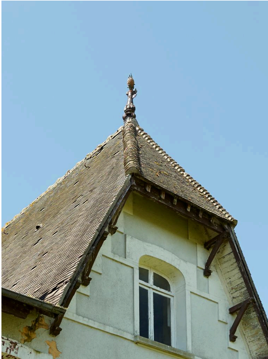
Détail de la croupette arrière et de l'épi de faîtage en forme d'ananas.
