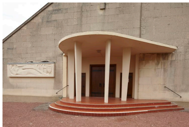
Détail du porche. Phot. Hubert Bouvet IVR31_20106200757NUCA
