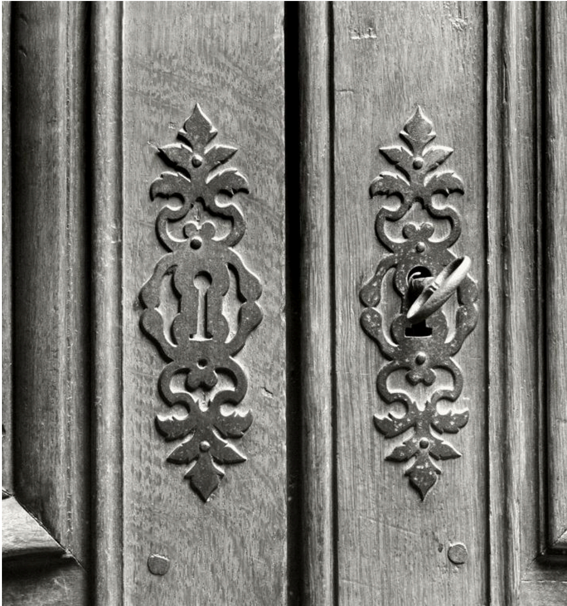
Détail des garnitures en fer forgé martelé à ornementation végétale stylisée.
