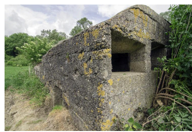
Vue générale vers nord Phot. Jean-Marc Ramette IVR32_20165901150NUCA
