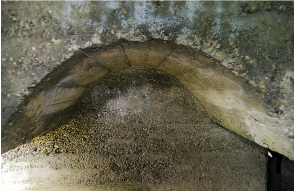
Sortie du poste d'observation. Voûte transversale, au couloir de distribution (au grand angulaire)
