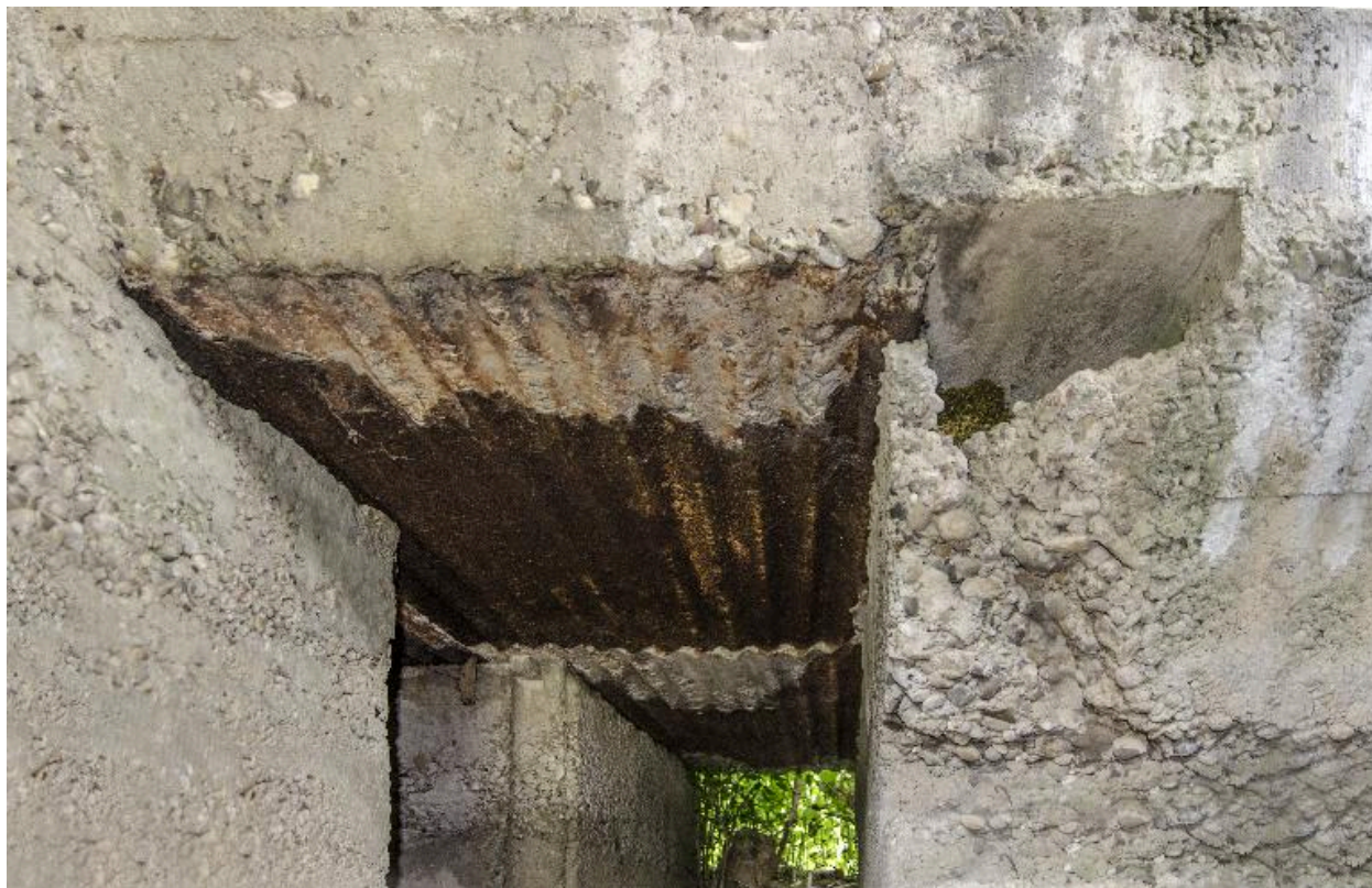
Couloir de distribution, détail du plaquage en tôle ondulée (au grand angulaire)
