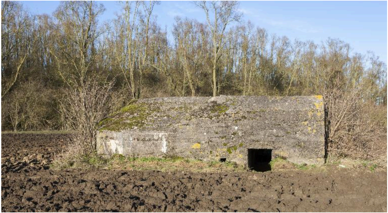
Vue latérale vers le nord-est
