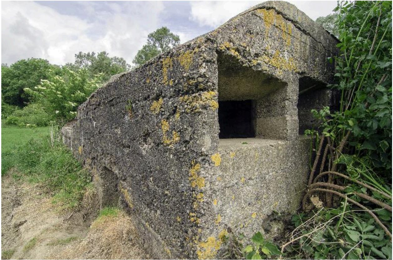
Vue générale vers nord
