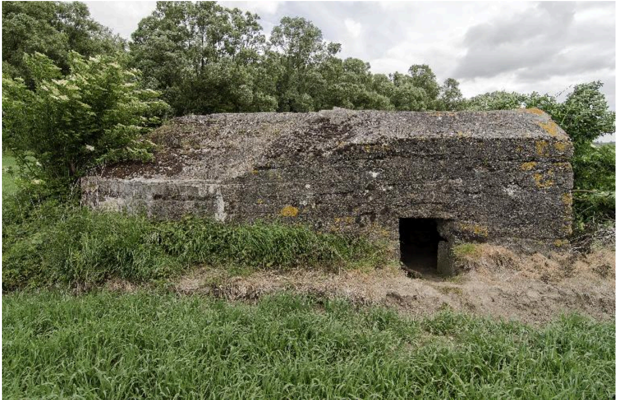
Vue latérale vers le nord-est. Entrée
