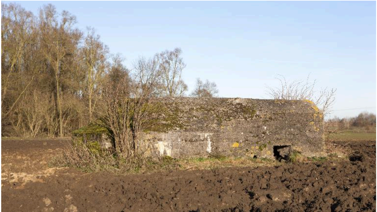
Vue latérale, vers le nord-est
