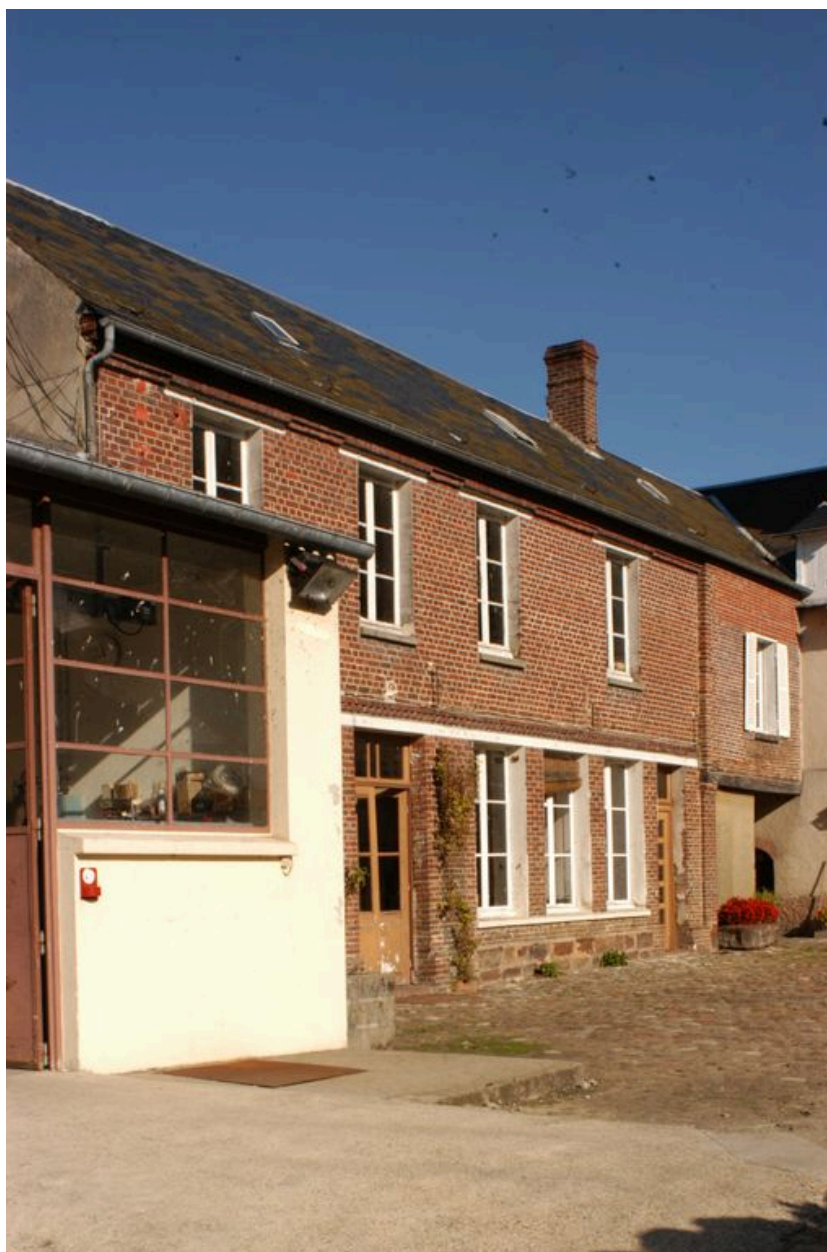
Les bureaux construits vers 1920.
