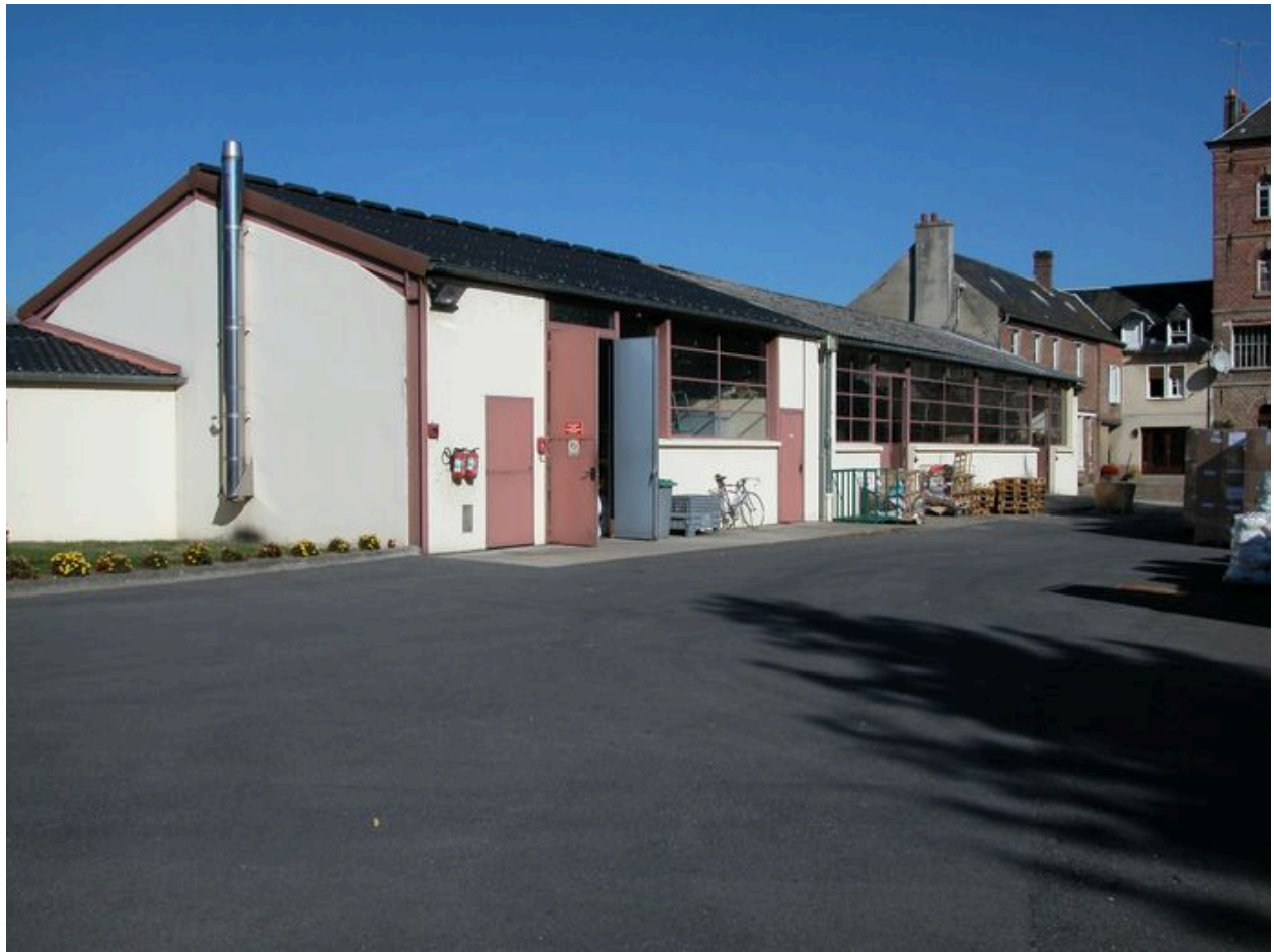
Atelier de fabrication construit en 1965.
