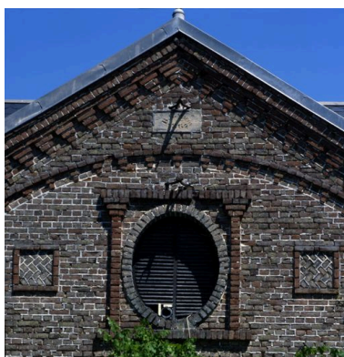
Pignon portant la date : 1864. Phot. Thierry Lefébure IVR22_20088000141XA
