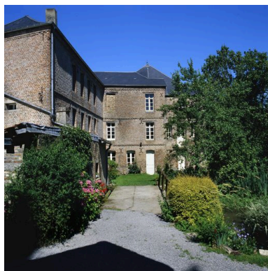
Vue d'ensemble de la façade arrière des bâtiments de la minoterie. Phot. Thierry Lefébure IVR22_20088000144XA
