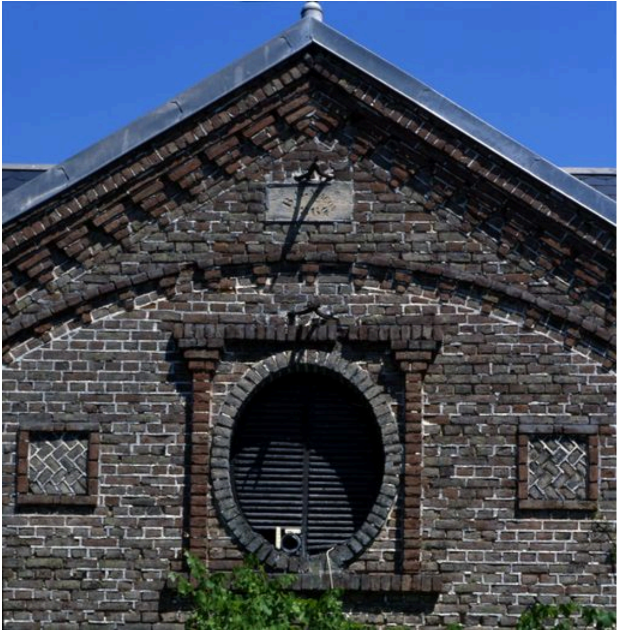
Pignon portant la date : 1864.
