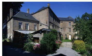
Vue générale postérieure de la minoterie et des dépendances. Phot. Thierry Lefébure IVR22_20088000147NUCA
