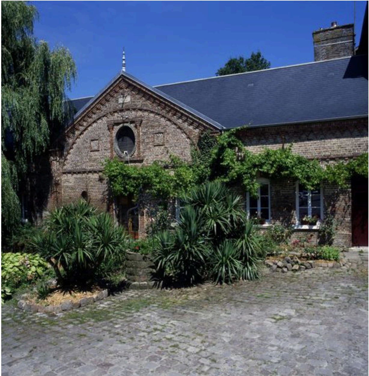
Vue du logement portant la date de 1864, façade sur cour.
