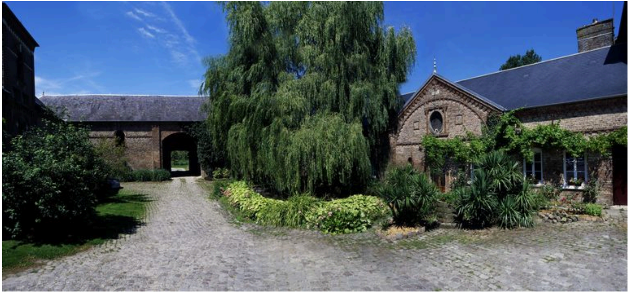
Vue générale du logement et de la remise agricole en retour.
