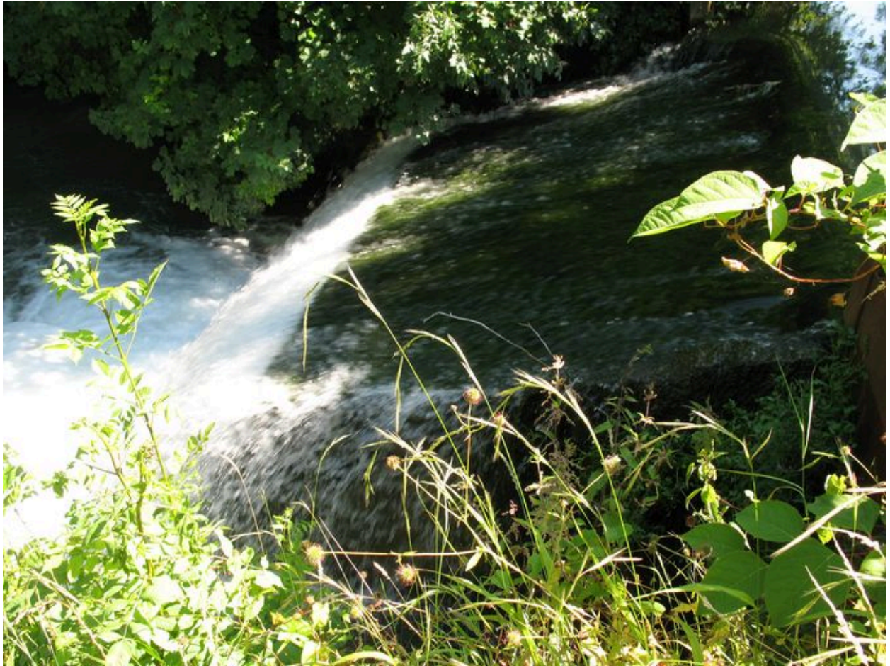
Déversoir du vannage de décharge.
