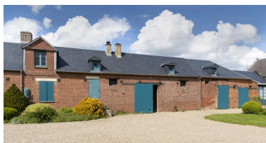
Anciens ateliers agricoles et écuries, vers 1907, vue depuis le sud. Phot. Marc Kérignard IVR32_20216000437NUCA
