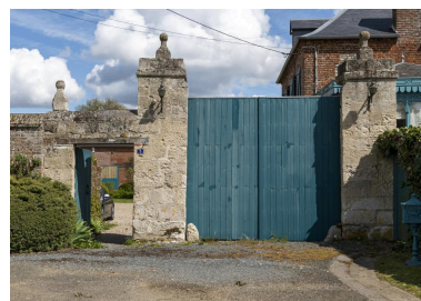
Portail d'entrée avec porte piétonne, vue depuis l'ouest. Phot. Marc Kérignard
