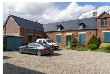
Ancien logis (des ouvriers?), vers 1907 pour la partie à droite et années 70 pour la partie en retour d'équerre, vue depuis le sud. Phot. Marc Kérignard IVR32_20216000441NUCA
