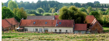
Vue cavalière depuis le nord. Phot. Frédéric Fournis IVR22_20098005455NUCA
