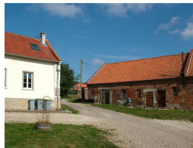
Vue partielle du logis, du portail et de l'ancienne étable à l'est. Phot. Frédéric Fournis IVR22_20098005464NUCA
