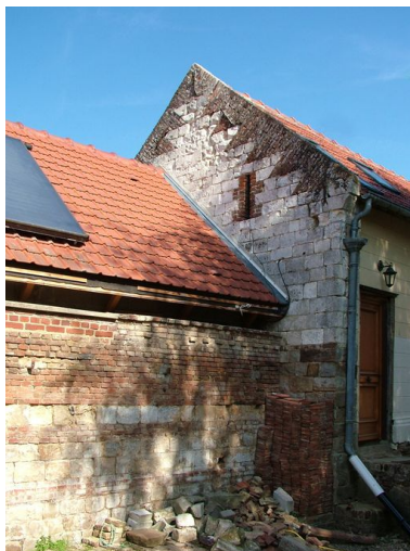
Vue partielle du pignon ouest du logis et du mur d'un bâtiment disparu. Phot. Frédéric Fournis IVR22_20098005467NUCA
