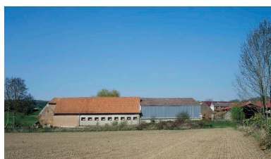
Vue générale depuis le sud. Phot. Marie-Laure Monnehay-Vulliet IVR22_20108000136XA
