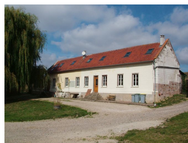
Vue du logis sur la cour. Phot. Frédéric Fournis IVR22_20098005456NUCA
