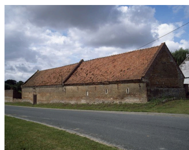
Vue des bâtiments d'exploitation depuis la route. Phot. Marie-Laure Monnehay-Vulliet IVR22_20098000242XA
