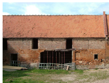
Vue de la grange bordant la cour à l'ouest. Phot. Frédéric Fournis IVR22_20098005460NUCA
