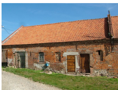
Vue de l'ancienne étable à l'est. Phot. Frédéric Fournis IVR22_20098005463NUCA
