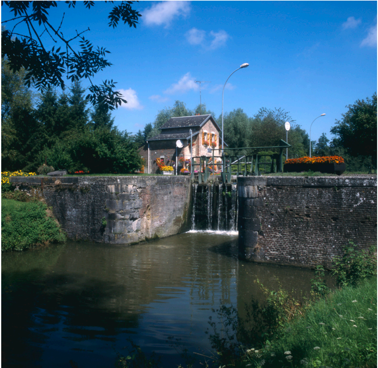
Vue de situation, depuis le canal.
