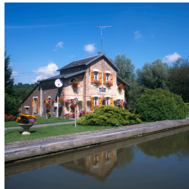
Vue d'ensemble de l'édifice, construit de 1834 à 1839 sur les plans de l'ingénieur Louis Joseph Etienne Cordier. Phot. Thierry Lefébure IVR22_20000202104XA
