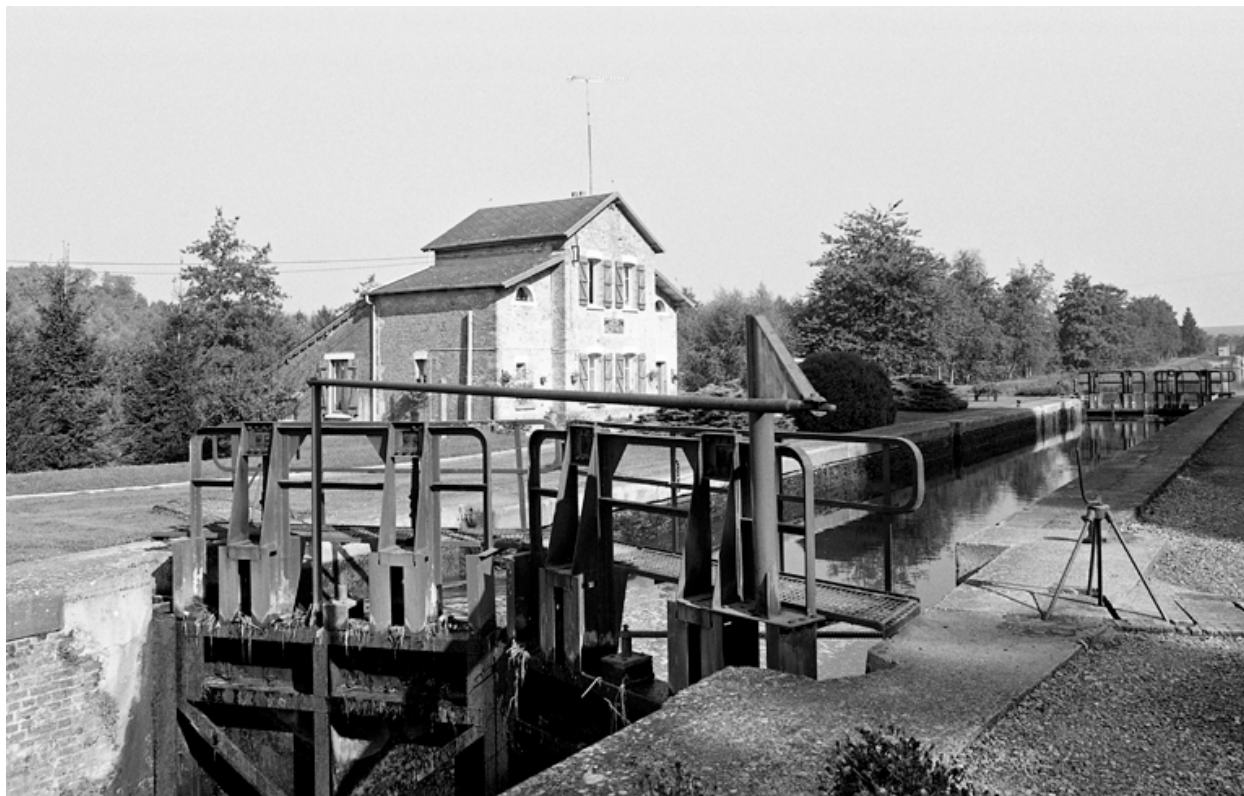
Vue sud de la maison éclusière et du sas, construits entre 1834 et 1839 sur les plans de l'ingénieur Louis Joseph Etienne Cordier.
