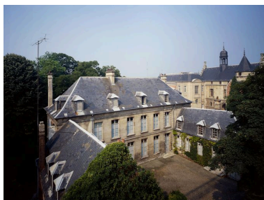
Elévation sur cour. Phot. Fabrice Charrondièrre IVR22_19866000104VA
