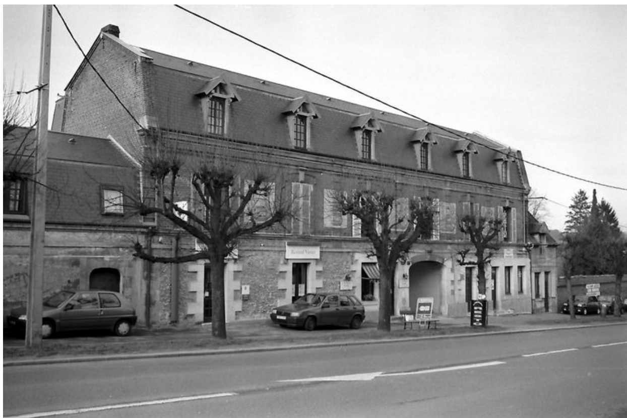
Façade sur rue, vue d'ensemble.
