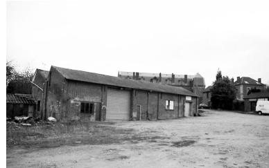
Ateliers de fabrication en sheds. Phot. Bertrand Fournier IVR22_20006000948Z
