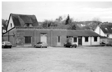
Ateliers de fabrication en fond de cour.
