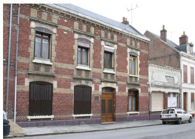
Vue de l'ancien logement patronal et des bureaux. Phot. Frédéric Pillet IVR22_20070205133NUCA
