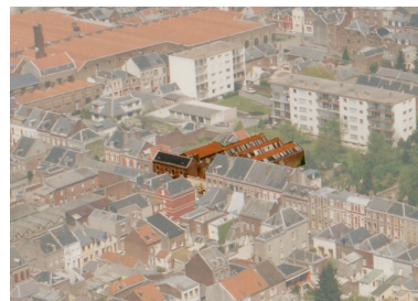
Vue aérienne du site en 1989. Phot. Pillet Frédéric IVR22_20060205624NUCAB
