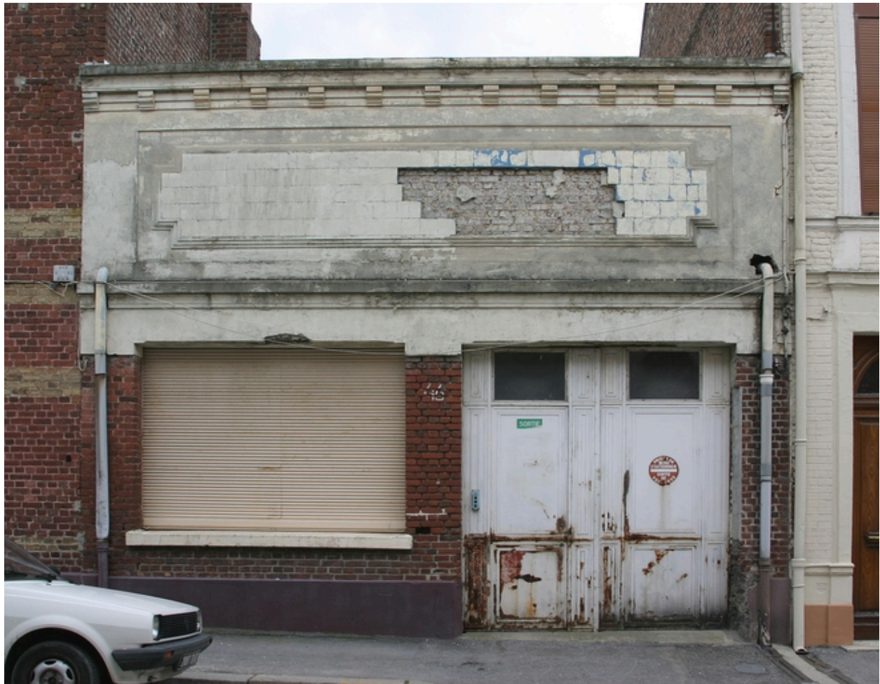
Entrée des ateliers.
