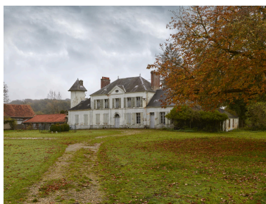
Vue générale du château du Moulinel prise depuis le nord-ouest Phot. Thierry Lefébure IVR22_20226200329NUCA
