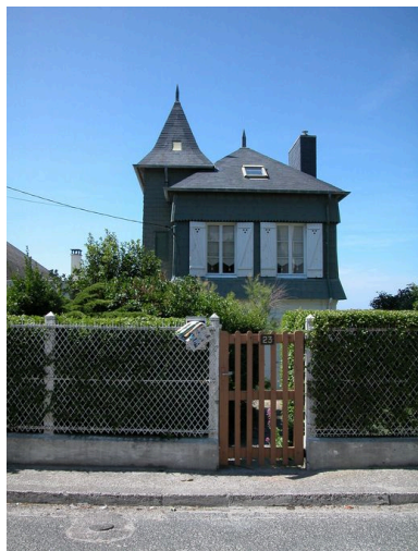
Vue d'ensemble depuis la rue Gros. Phot. Elisabeth Justome IVR22_20058002989NUCA
