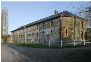
Etables surmontées de fenil construites en brique avec remplissage de blocage de galets.
