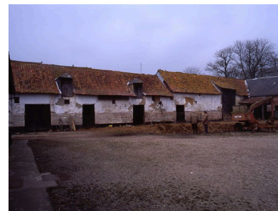
Bâtiments agricoles construits en torchis et pans de bois sur solin de brique avec couverture en pannes picardes.
