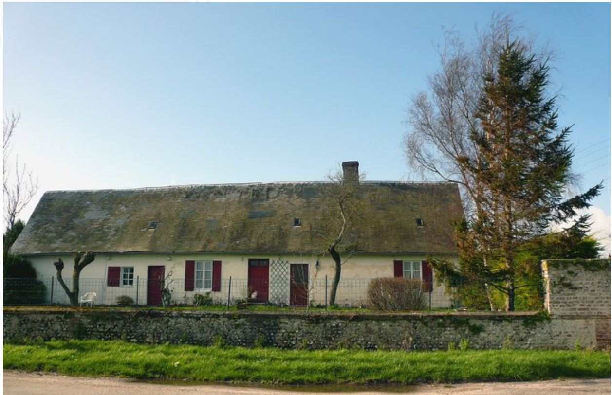
Exemple de logis d'une ferme traditionnelle de l'arrière-pays maritime.
