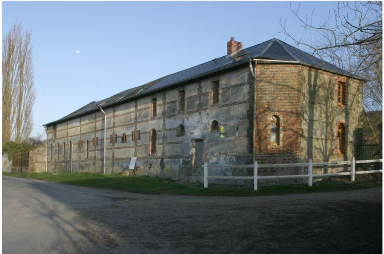
Etables surmontées de fenil construites en brique avec remplissage de blocage de galets.
