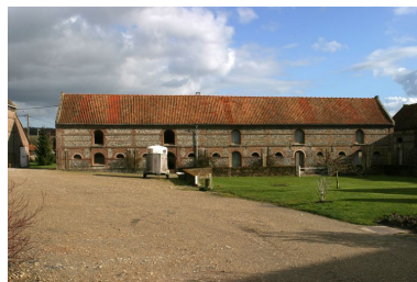
Etables composées d'une structure en brique avec remplissage de blocage de silex.
