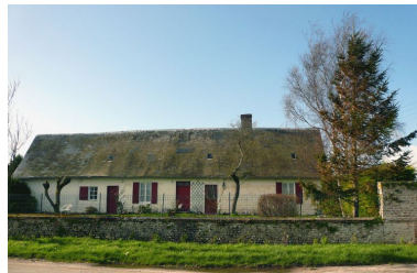
Exemple de logis d'une ferme traditionnelle de l'arrière-pays maritime.
