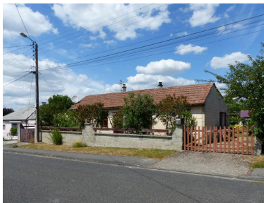
Maison chemisée ou reconstruite en briques. 5 boulevard Aristide-Briand. Phot. Isabelle Barbedor IVR32_20208005140NUCA
