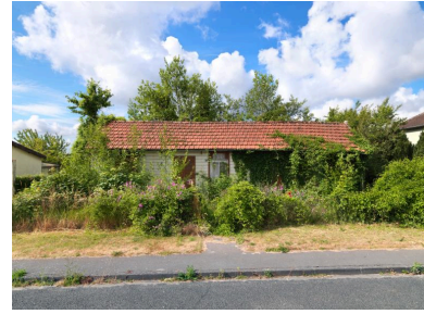
Maison conservée dans son état d'origine. Boulevard Aristide-Briand. Phot. Thierry Lefébure IVR32_20208000141NUC2A
