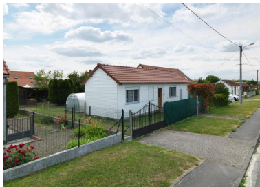
Maison restaurée, boulevard Jean-Jaurès. Phot. Thierry Lefébure IVR32_20208000138NUC2A
