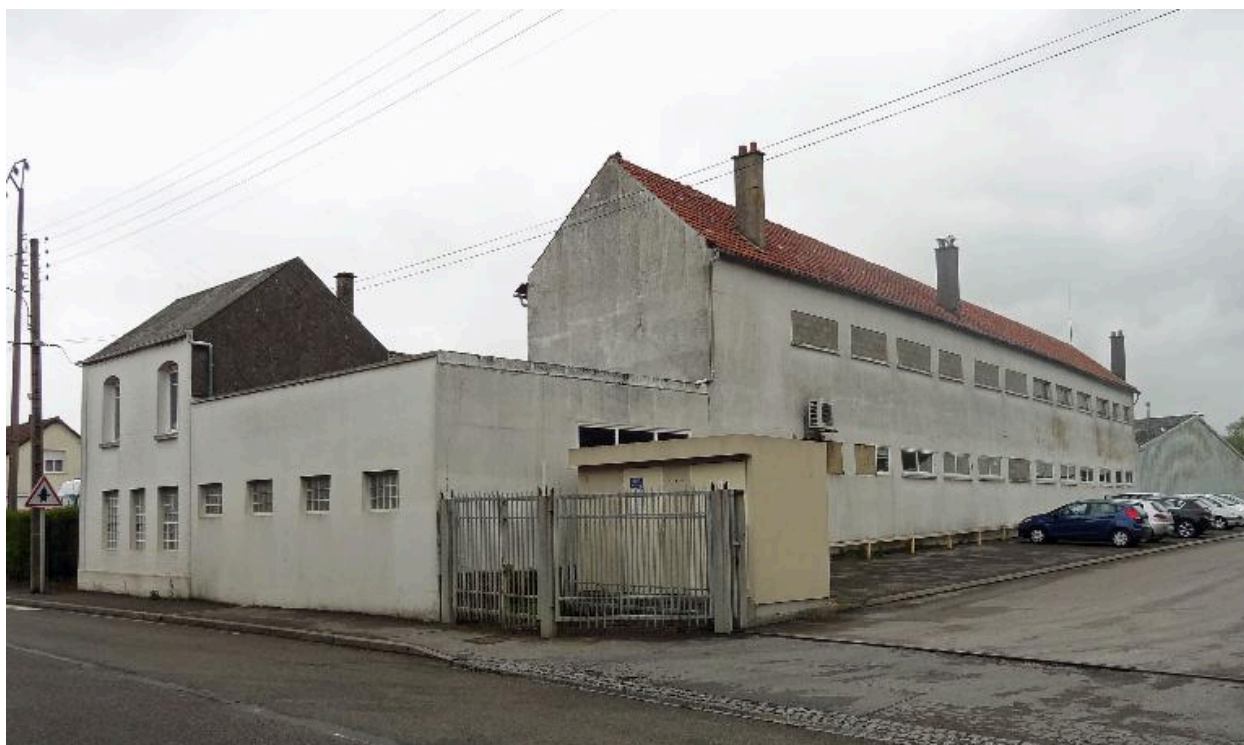
Vue générale de l'arrière des premiers bâtiments de l'usine, depuis la rue Henri Barbusse.
