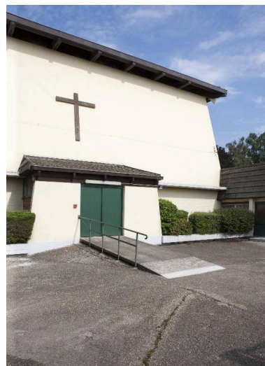
Élévation antérieure de l'église. Phot. Pierre Thibaut IVR31_20155900133NUCA
