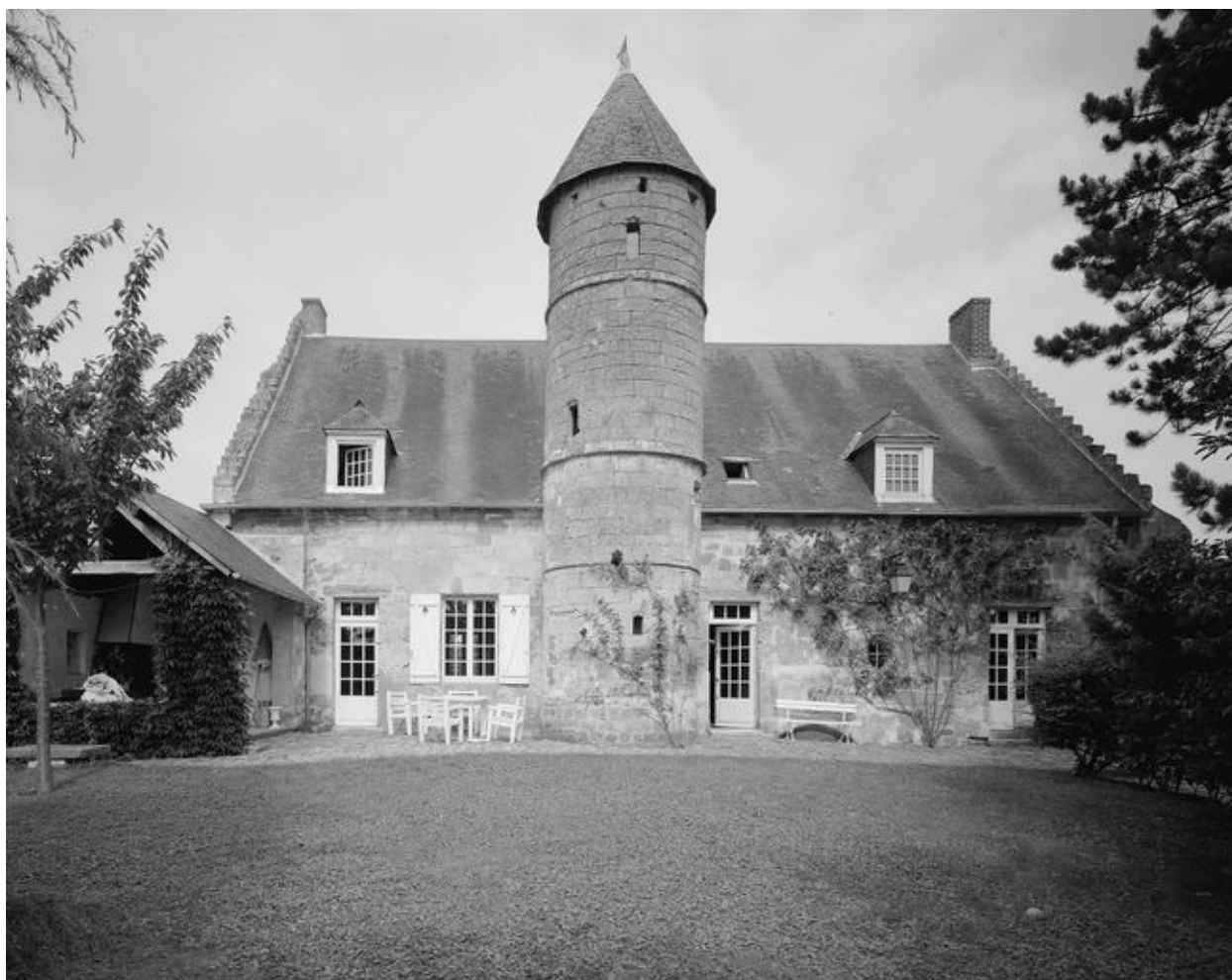
Logis. Elévation antérieure.
