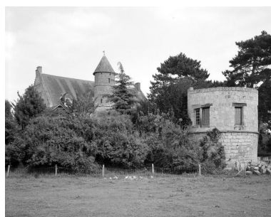
Vue générale. Phot. Jean-Michel Perrin IVR22_19846001180V
