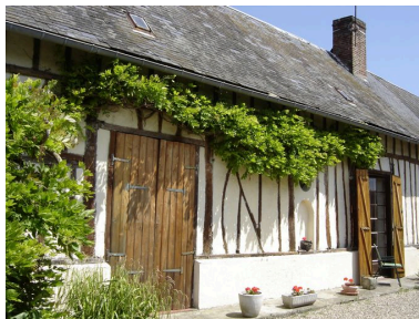
Vue latérale depuis la cour. Phot. Inès Guérin IVR22_20058006033NUCA
