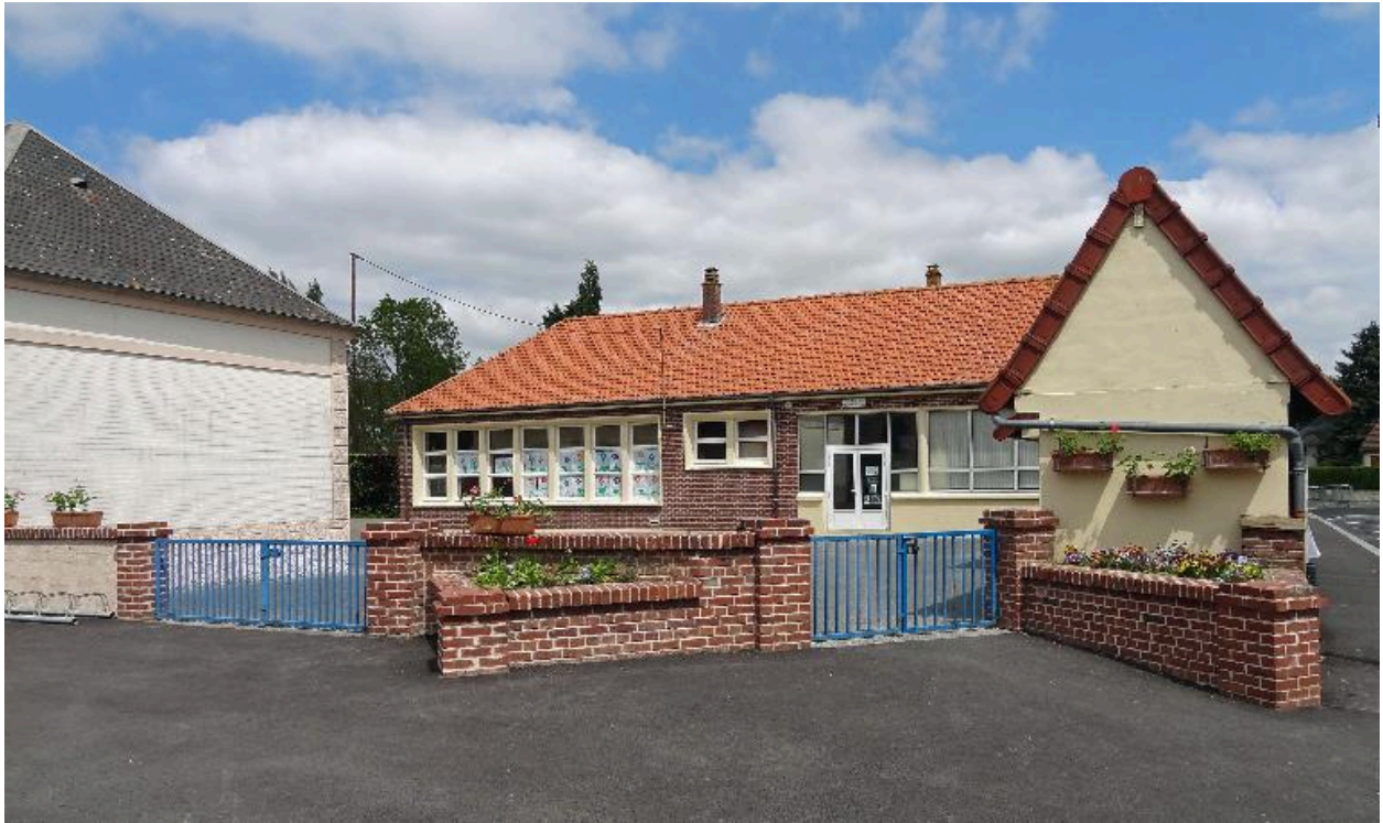
Le bâtiment des salles de classe.
