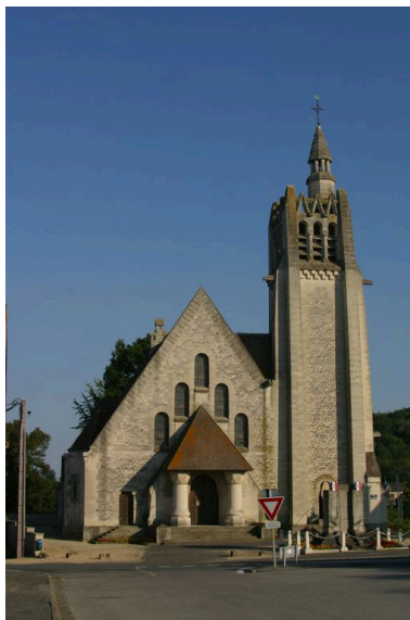
Vue générale. Phot. Inès Guérin IVR22_20030202237NUCA
