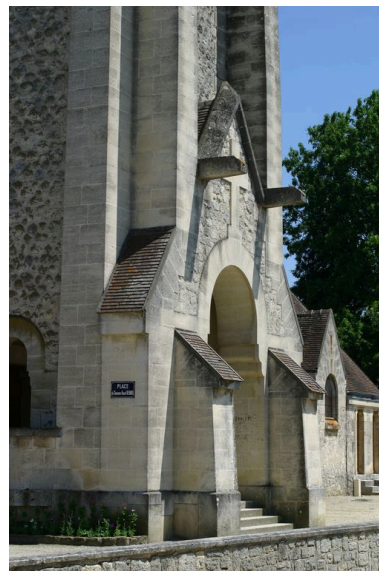
Vue du portail sud. Phot. Inès Guérin IVR22_20030202239NUCA
