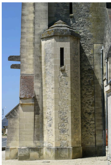
Vue d'une tour d'angle. Phot. Inès Guérin IVR22_20030202238NUCA
