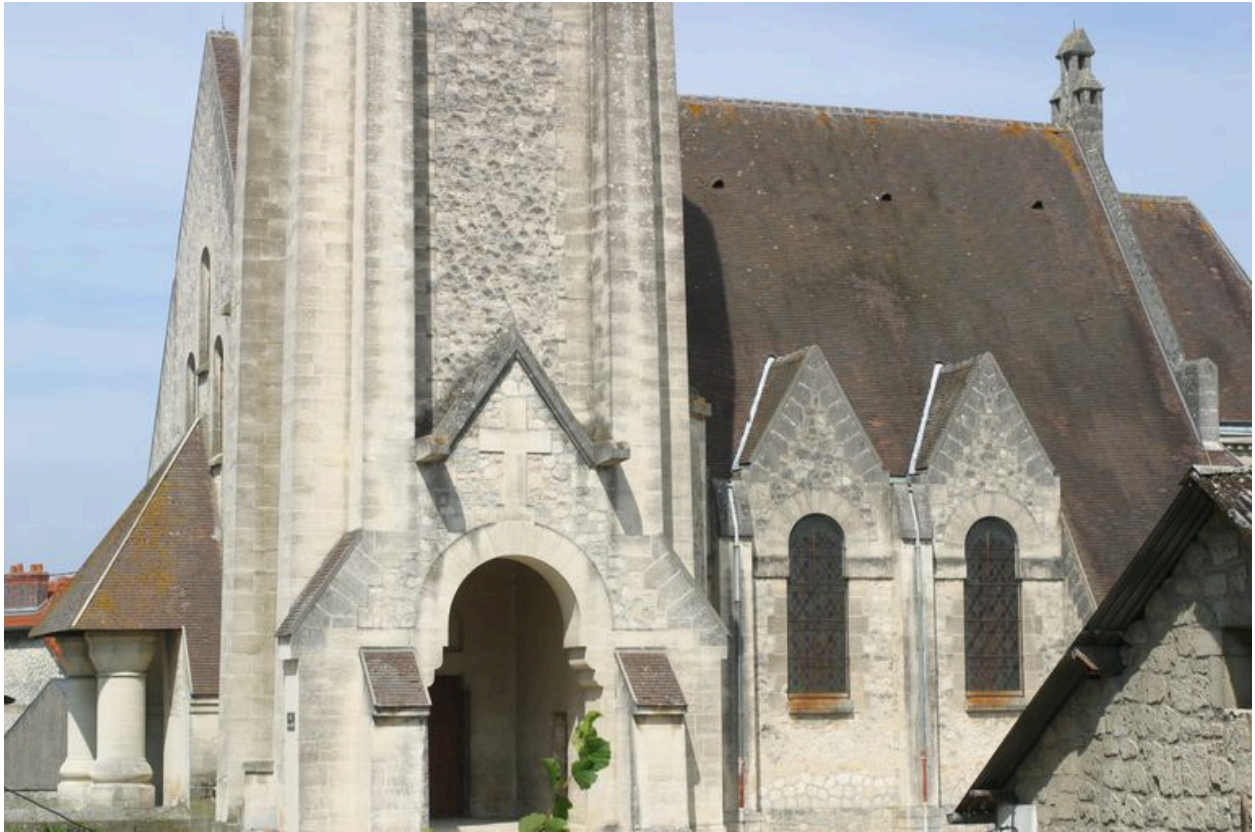
Vue de la face sud.
