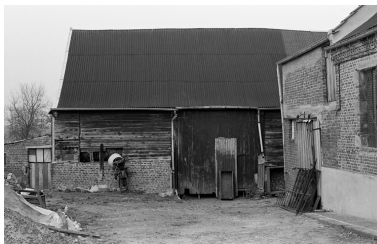
Elévation sur cour de la grange. Phot. Christiane Riboulleau IVR22_19920201671Z
