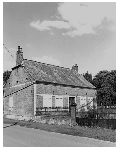
Logis depuis la rue. Phot. Xavier-Philippe Guiochon IVR22_19980202359Z
