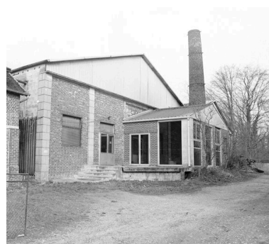
Vue générale extérieure du pignon ancien de l'atelier de fabrication depuis l'entrée de l'usine.
