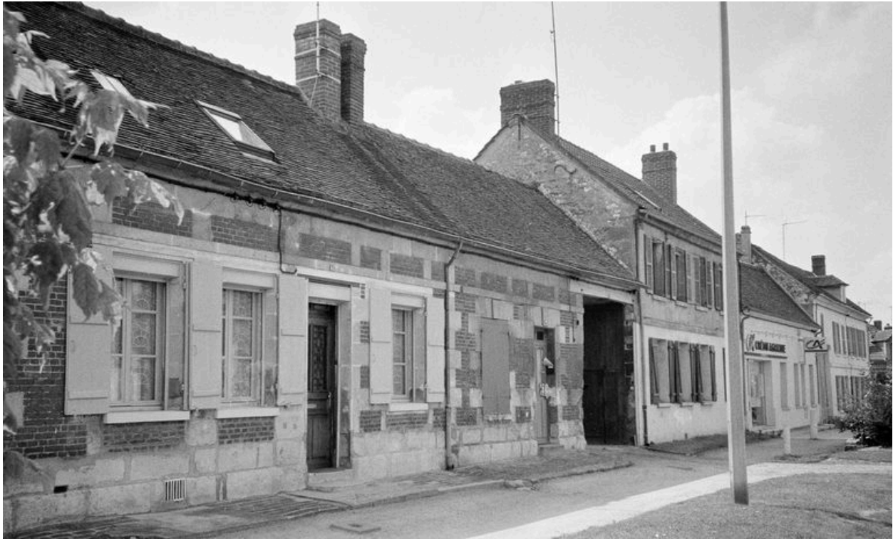
Logement et entrée charretière attenante, vue d'ensemble sur rue.
