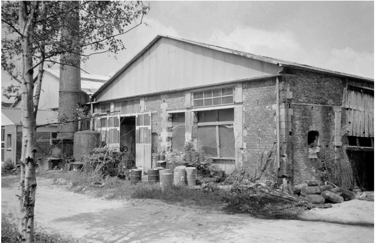
Atelier de fabrication : flanc est.
