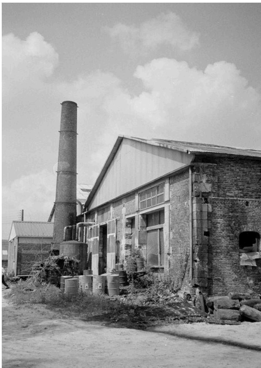
Atelier de fabrication, flanc est.
