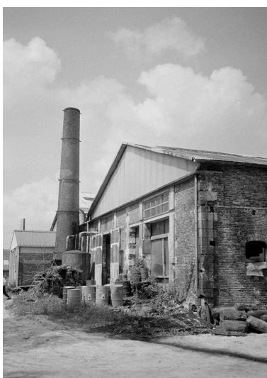
Atelier de fabrication, flanc est.
