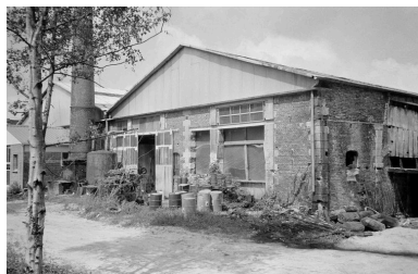
Atelier de fabrication : flanc est. Phot. Benoît Dufournier IVR22_19936001617Z
