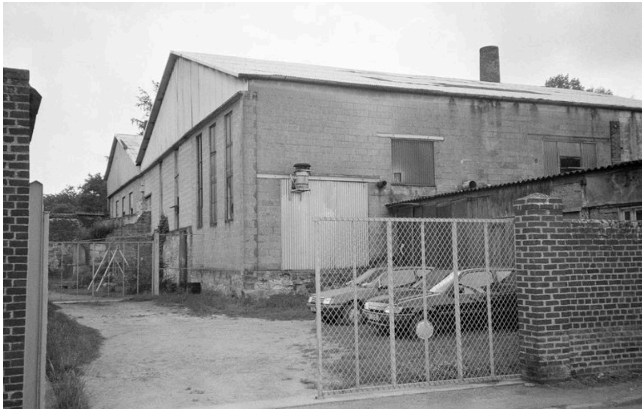
Vue générale : flanc ouest.
