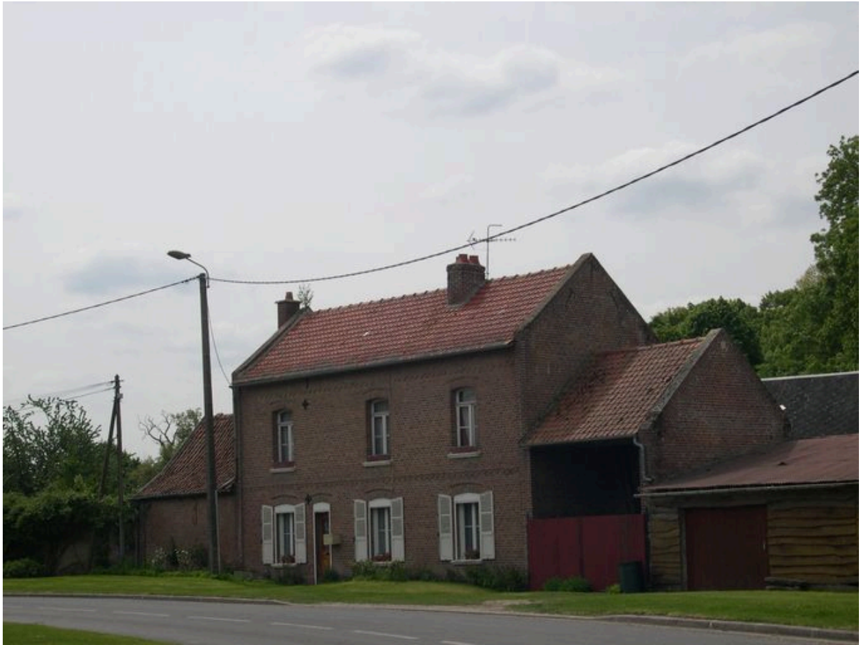
Maison, 12 rue de l'Eglise.
