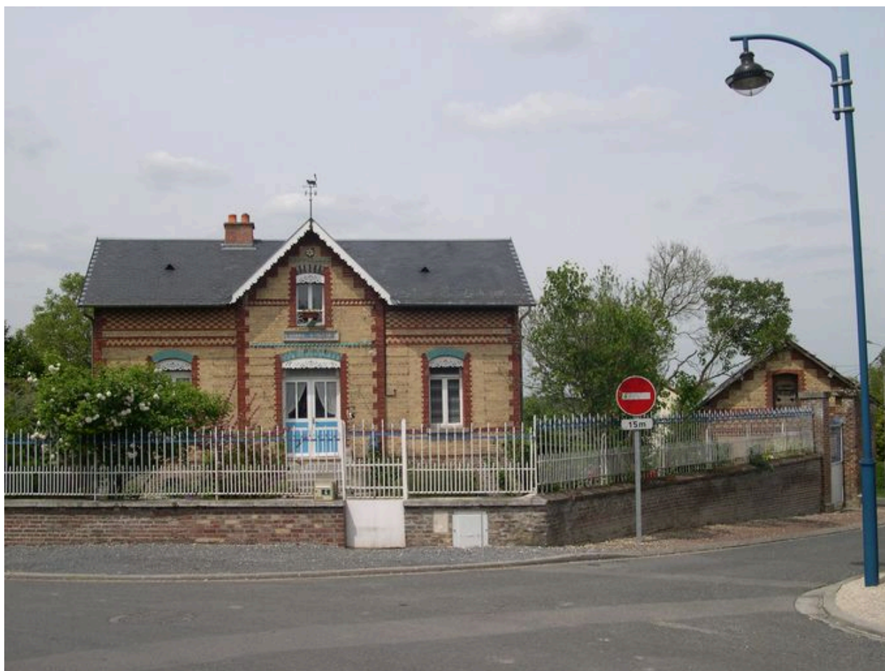
Maison, 4 rue du Puits, début 20e siècle.
