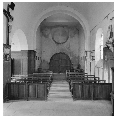
Vue intérieure de l'église, depuis le chœur vers l'entrée. Phot. Christiane Riboulleau IVR22_19880201010X
