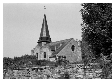
Vue générale depuis le sud-est. Phot. Christiane Riboulleau IVR22_19880200804X
