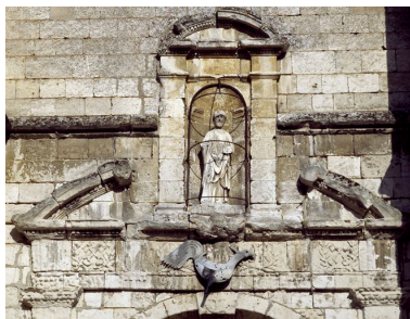
Frise, fronton brisé et édicule à niche. Phot. Marie-Laure Monnehay-Vulliet IVR22_20108000329XA
