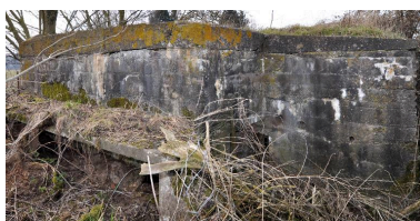
Élévation sud-est : Entrée, au centre, et banquette de tir, à gauche. Phot. Jean-Marc Ramette IVR31_20145905465NUCA
