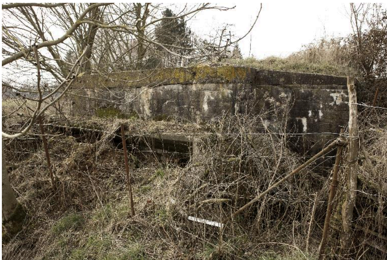
Vue générale vers le nord-ouest depuis la route du Bas-Flandre
