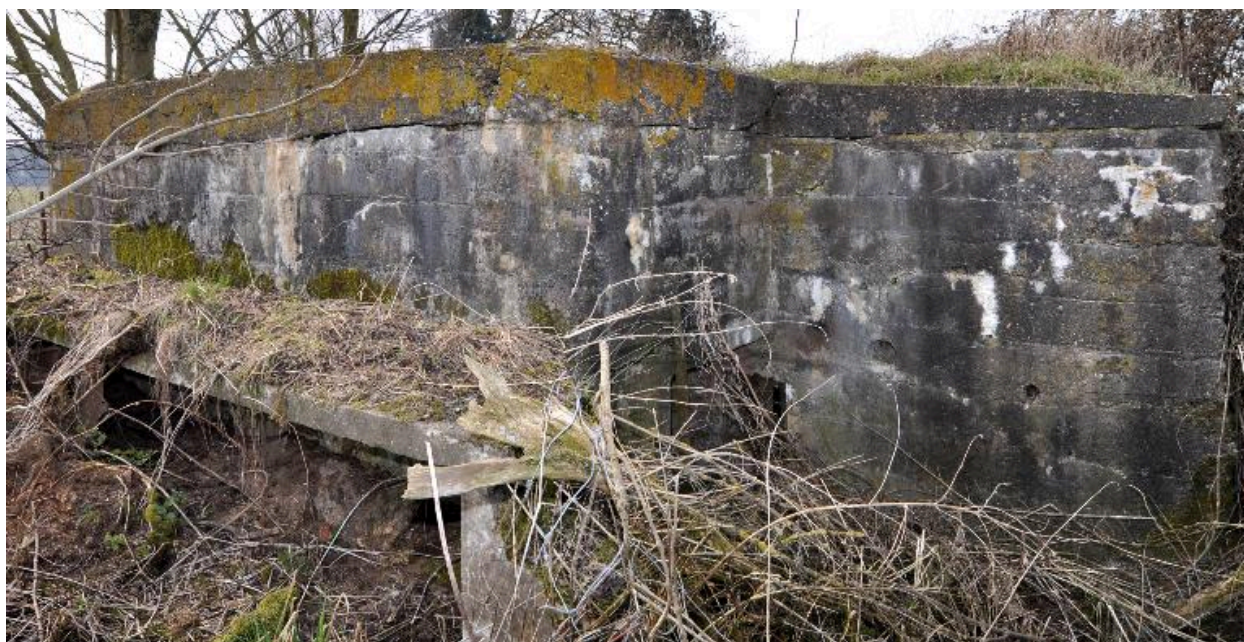
Elévation sud-est : Entrée, au centre, et banquette de tir, à gauche.
