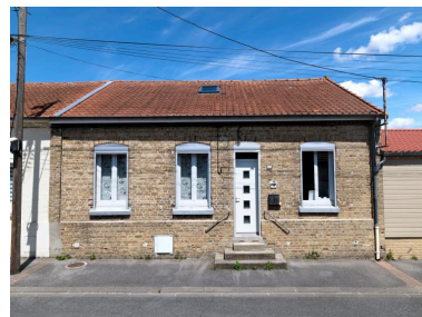
Vue de la façade d'un logement de la partie ouest de la cité. Phot. Thierry Lefébure IVR32_20208000134NUC2A
