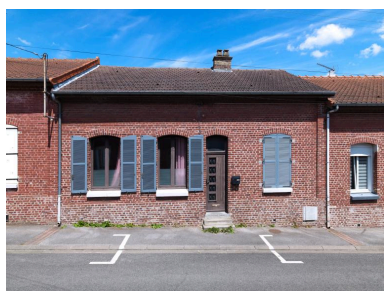
Vue de la façade d'un logement de la partie est de la cité. Phot. Thierry Lefébure IVR32_20208000132NUC2A
