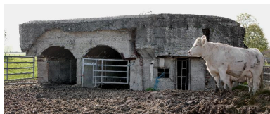
Vue générale vers le sud-ouest Phot. Jean-Marc Ramette IVR31_20145904873NUCA
