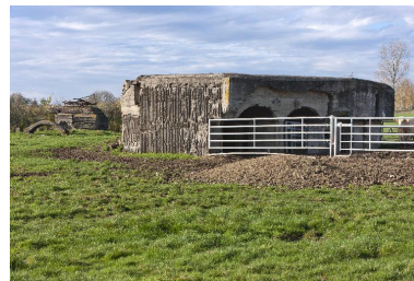
Vue de trois-quarts, vers le nord-est Phot. Jean-Marc Ramette IVR31_20145904872NUCA
