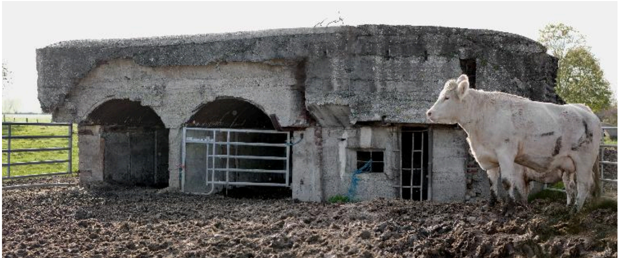
Vue générale vers le sud-ouest
