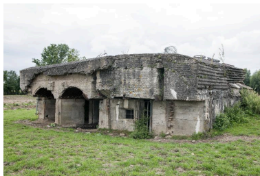
Vue générale vers le sud-ouest Phot. Pierre Thibaut IVR31_20155901471NUCA
