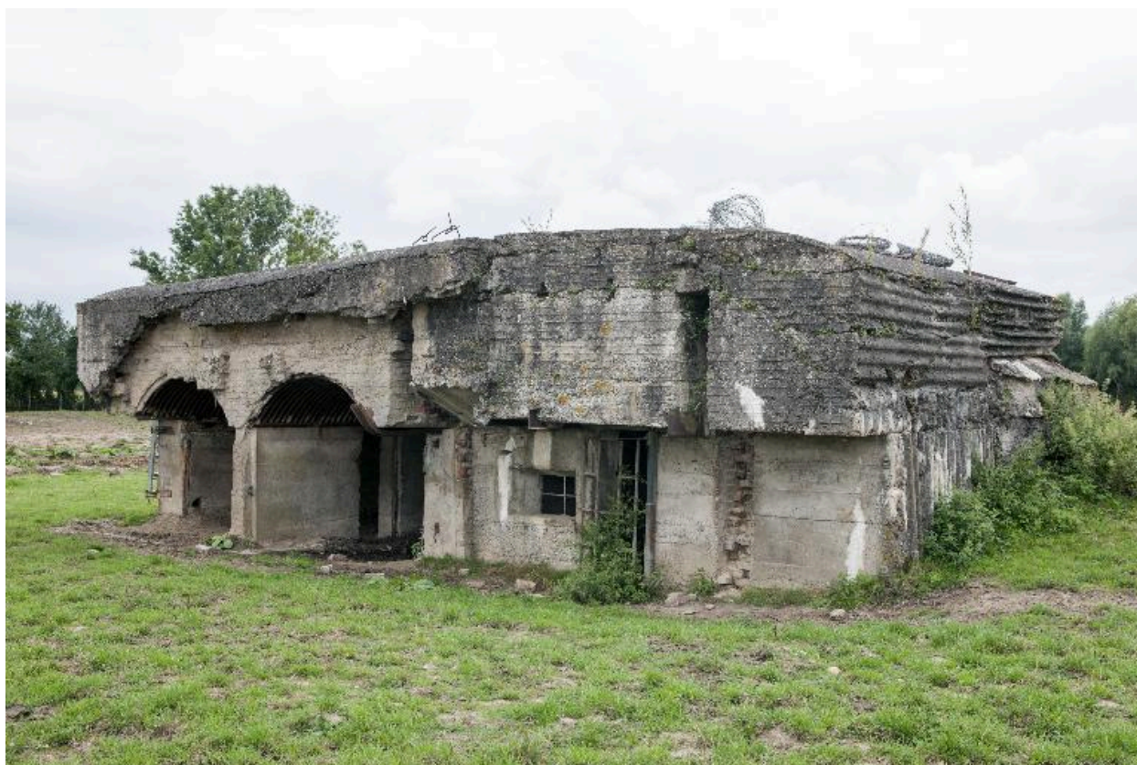
Vue générale vers le sud-ouest
