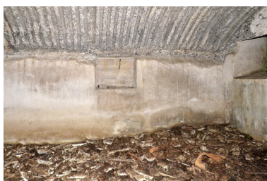
Seconde salle nord. A droite la baie sur le couloir. En face une niche Phot. Jean-Marc Ramette IVR32_20176200298NUCA
