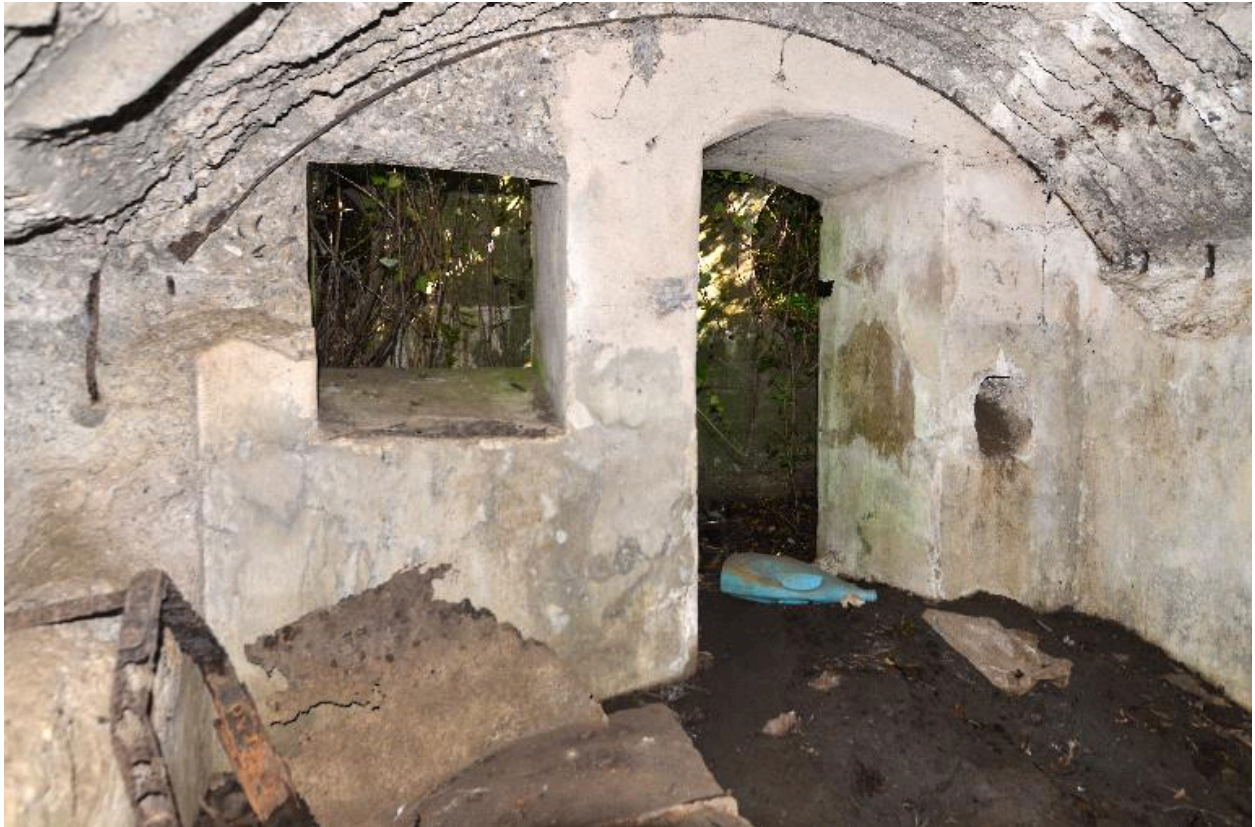
Première salle nord : porte sur le couloir encadrée d'une baie ébrasée et d'un conduit de cheminée
