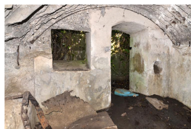
Première salle nord : porte sur le couloir encadrée d'une baie ébrasée et d'un conduit de cheminée Phot. Jean-Marc Ramette IVR32_20176200300NUCA
