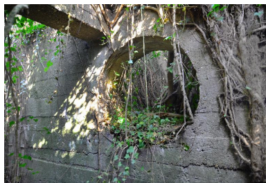
Depuis le couloir, un des oculi du mur de soutènement avec le départ d'un contrefort Phot. Jean-Marc Ramette IVR32_20176200302NUCA
