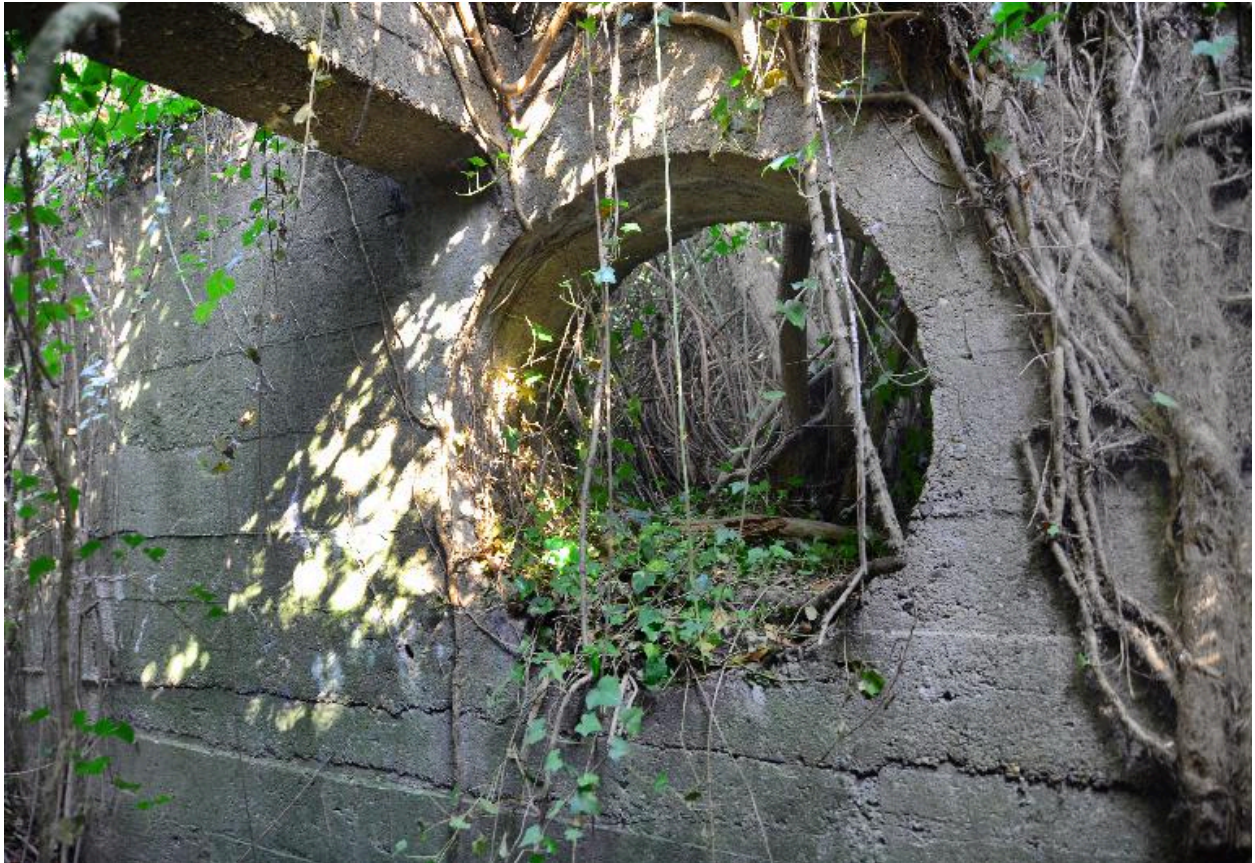
Depuis le couloir, un des oculi du mur de soutènement avec le départ d'un contrefort
