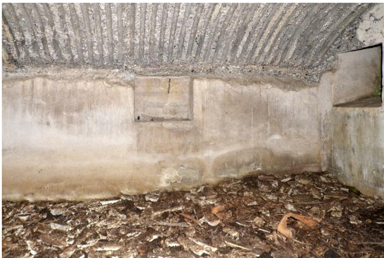
Seconde salle nord. A droite la baie sur le couloir. En face une niche
