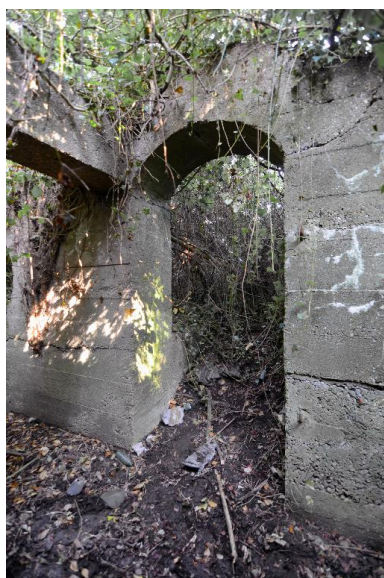
Depuis le couloir, la porte dans le mur de soutènement avec le départ d'un contrefort Phot. Jean-Marc Ramette IVR32_20176200291NUCA
