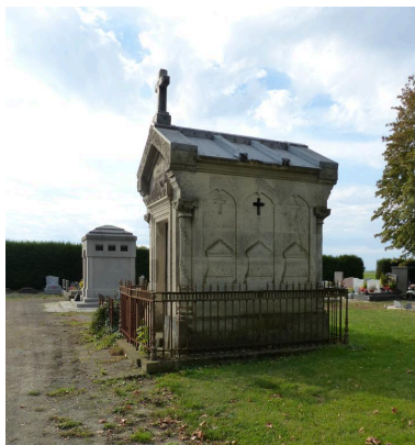
Vue de trois-quart, depuis le sud-est. Phot. Isabelle Barbedor IVR32_20188005115NUCA
