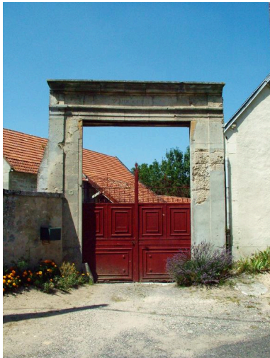
Vue du portail d'une ferme. Phot. Frédéric Fournis IVR22_20040202976NUC1A
