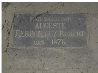
Cartouche commémoratif de construction. Phot. Sophie Luchier IVR31_20045905483NUCA
