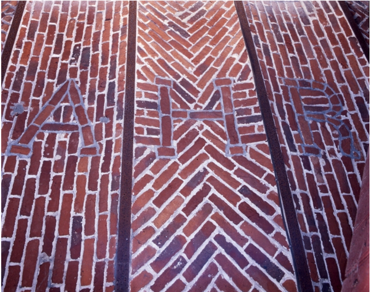
Les voûtes des écuries.
