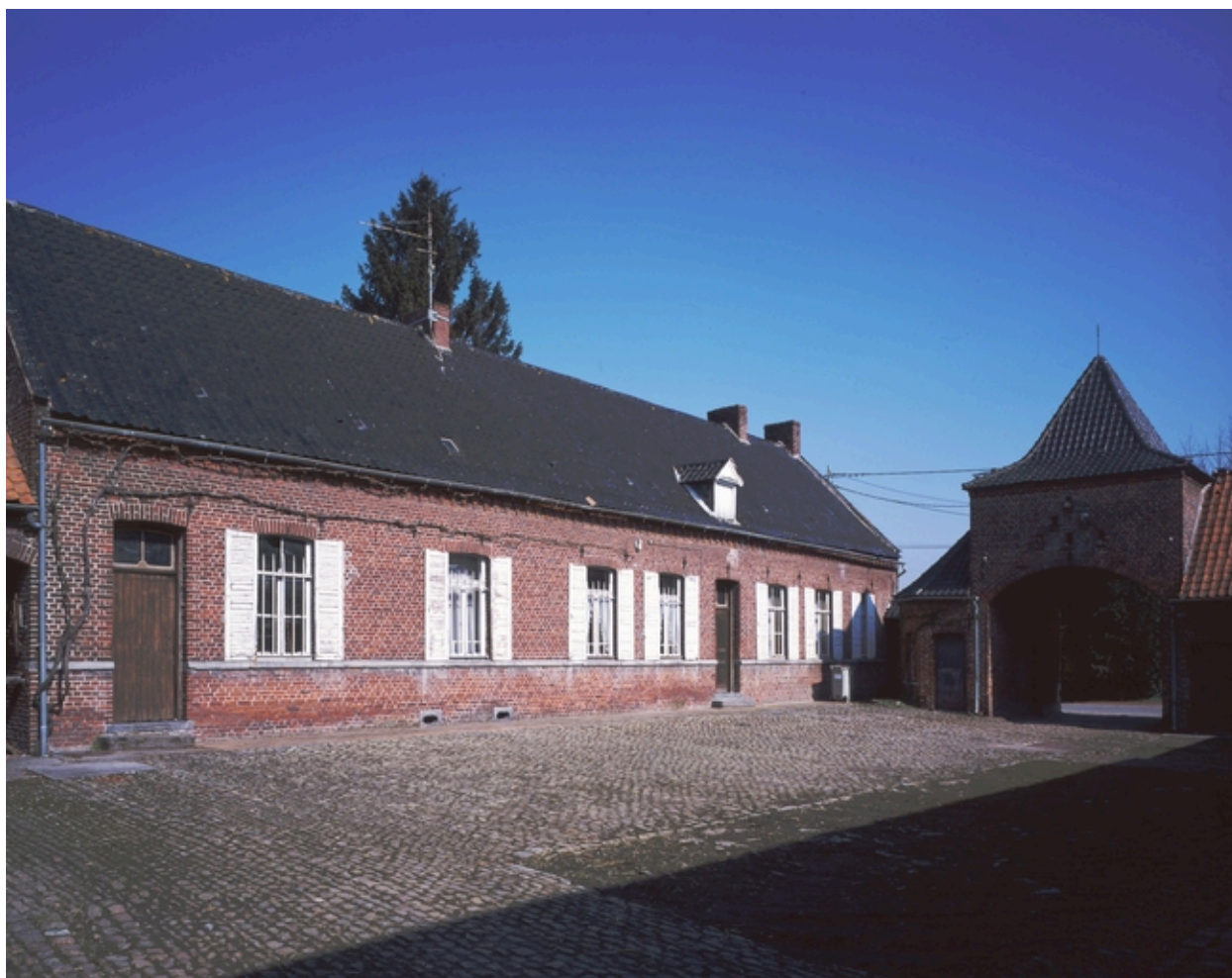
Vue générale depuis la cour : le logis et le pigeonnier-porche.
