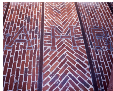
Les voûtes des écuries. Phot. Pierre Thibaut IVR31_20095902002XA
