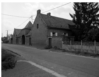
Vue générale de la ferme de trois quarts depuis la rue. Phot. Philippe Dapvril IVR31_20055900969X
