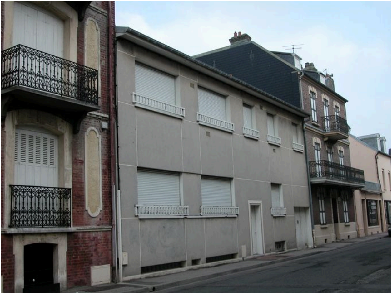
Immeuble à logements, 23 rue Buzeaux (1982 AH 654).
