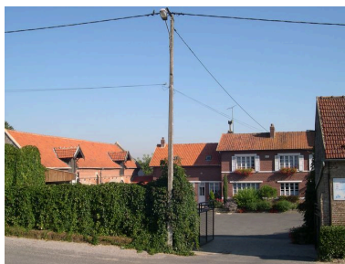
La ferme du château, vue du sud-est. Phot. Isabelle Barbedor IVR22_20038010736NUCA
