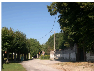
Le mur sud de la propriété, face à l'ancien bassin. Phot. Isabelle Barbedor IVR22_20038010737NUCA
