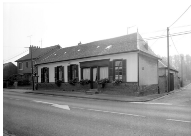
Vue générale. Phot. Thierry Lefébure IVR22_19978000704V
