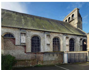
Vue extérieure de la nef du côté est. Phot. Thierry Lefébure IVR22_20138000514NUC2A
