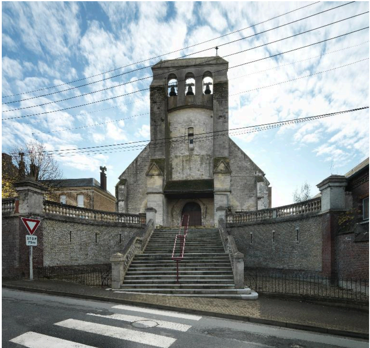
Vue d'ensemble nord de l'église.
