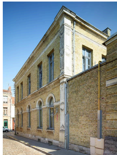
Vue depuis le sud. Phot. Pierre Thibaut IVR32_20166200372NUCA
