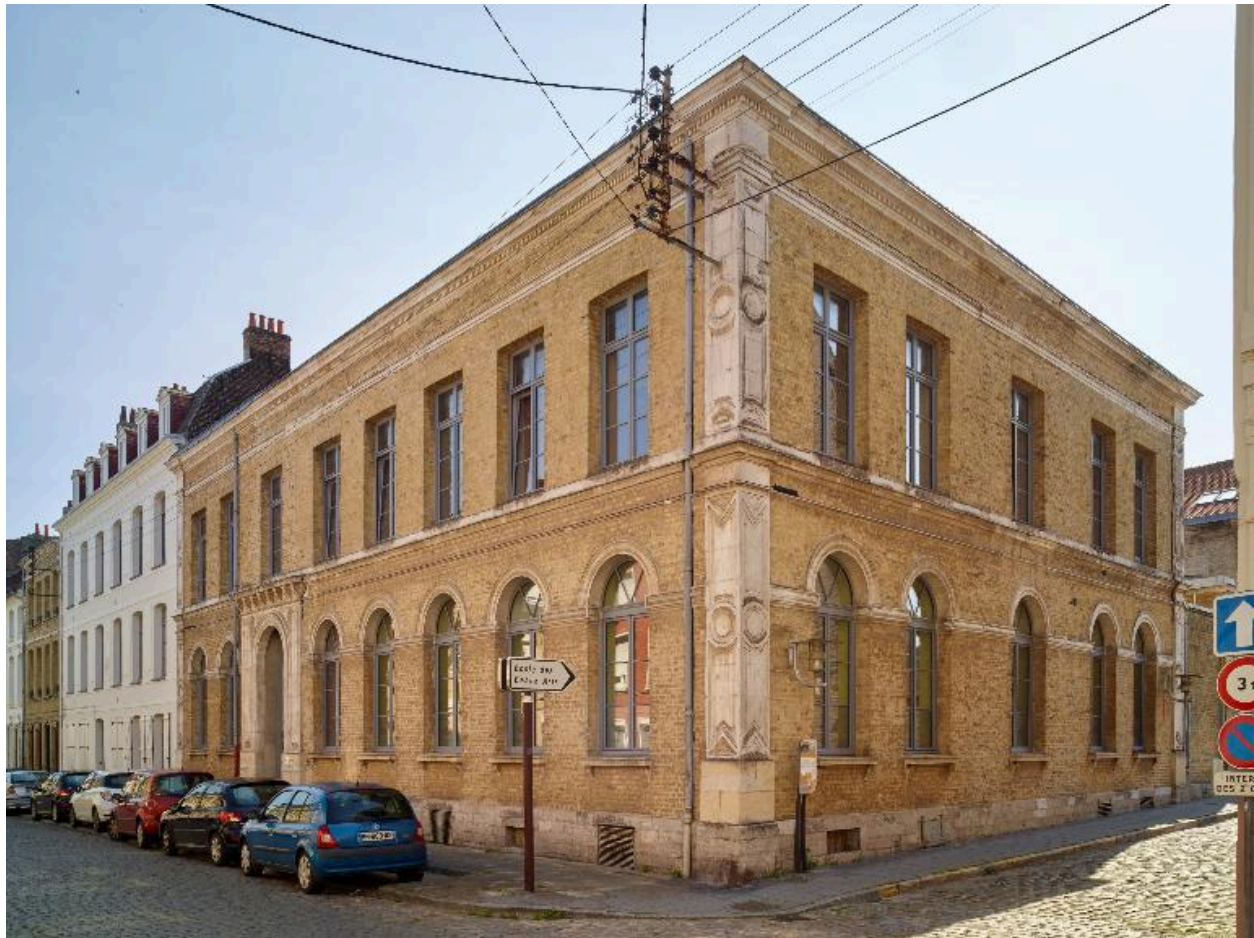
Vue de trois quart, depuis le sud ouest.
