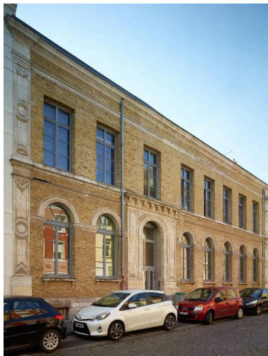
Vue de trois quart de la façade, vers le sud ouest. Phot. Pierre Thibaut IVR32_20166200370NUCA
