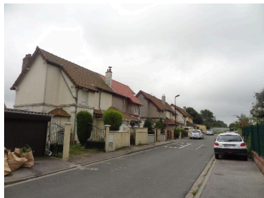
Immeuble à logements locatifs rue Sainte-Cécile : vue générale. Phot. Frédéric-Nicolas Kocourek IVR22_20148005092NUC2A
