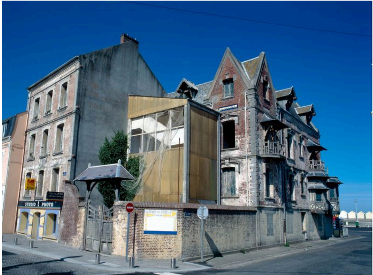
Elévation postérieure, rue du Général-Leclerc.
