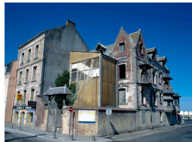
Elévation postérieure, rue du Général-Leclerc. Phot. Marie-Laure Monnehay-Vulliet IVR22_20038000678XA
