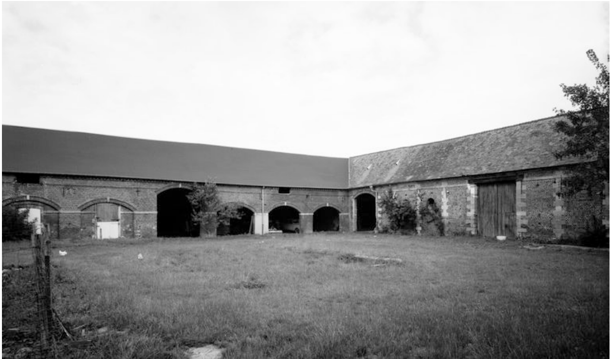
Ferme. Vue générale.
