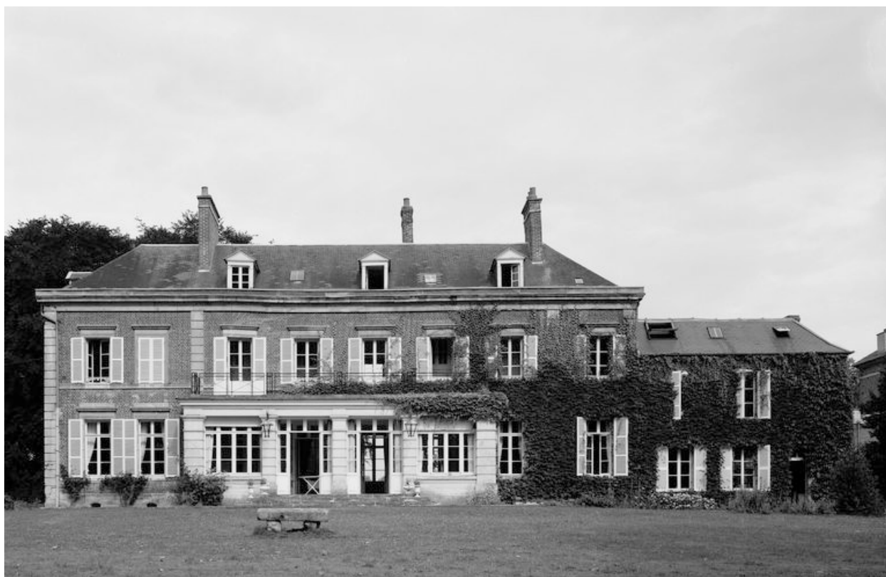
Logis. Elévation postérieure.
