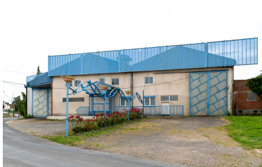
Ateliers dans la rue de Paillart. Phot. Marc Kérignard IVR32_20246000685NUCA
