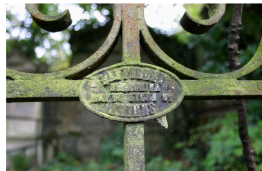
Signature du serrurier Laffillée (portillon de clôture). Phot. Caroline Vincent IVR22_20068001564NUCA
