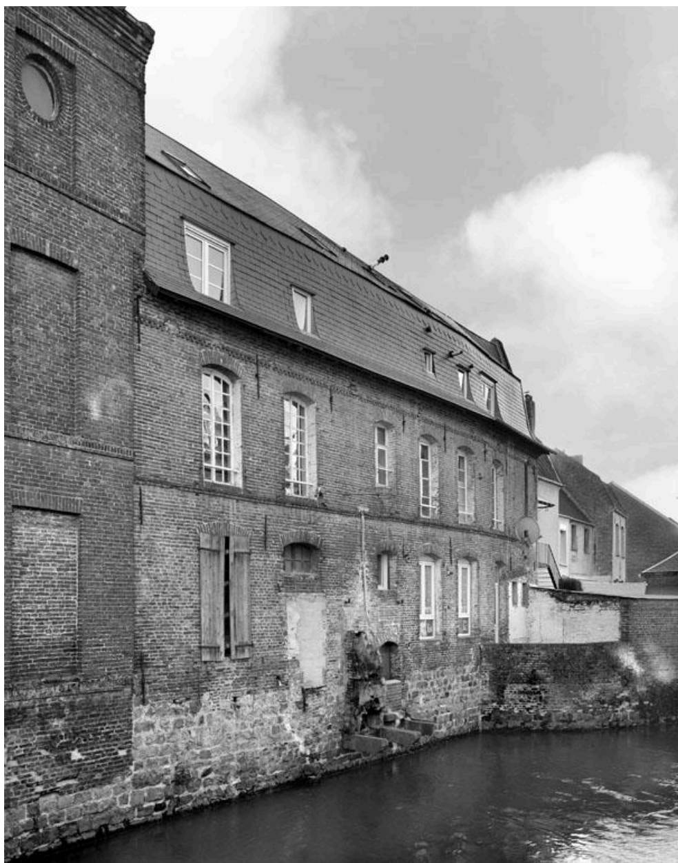
Vue de la façade arrière sur le canal des Moulins.
