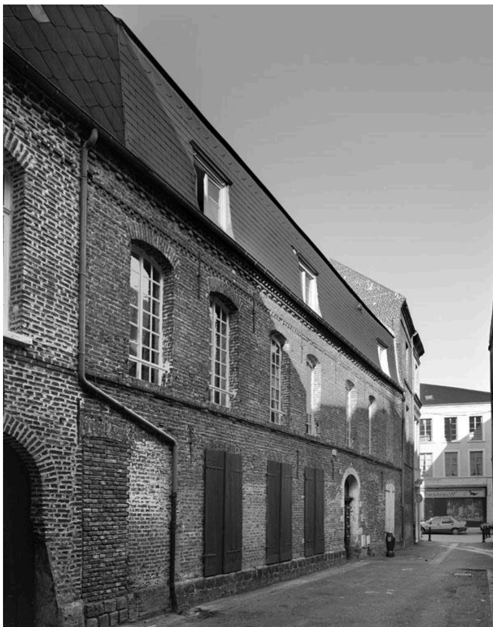
Vue de la façade principale sur la rue.
