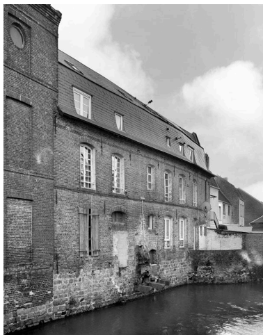
Vue de la façade arrière sur le canal des Moulins. Phot. Thierry Lefébure IVR22_20020201112V
