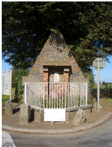
Vue du monument commémoratif situé au carrefour. Phot. Inès Guérin IVR22_20068005332NUCA
