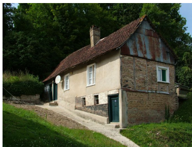
Vue générale. Phot. Frédéric Fournis IVR22_20098005268NUCA
