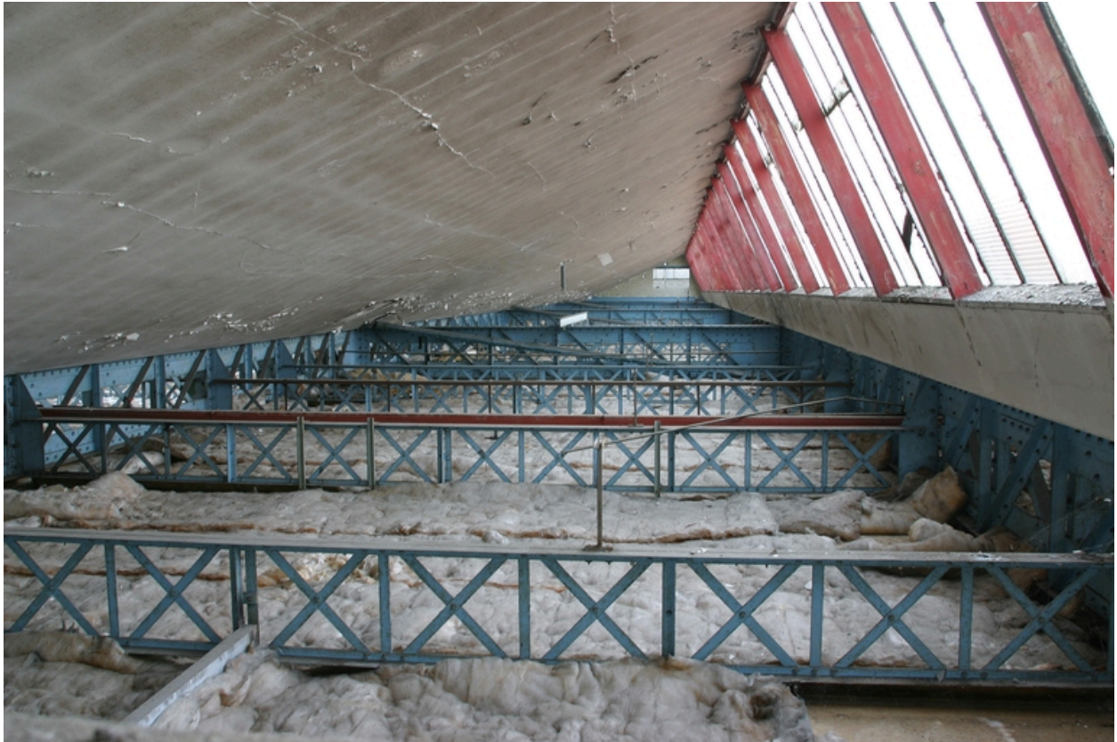
Vue de la structure des sheds, au-dessus des ateliers.
