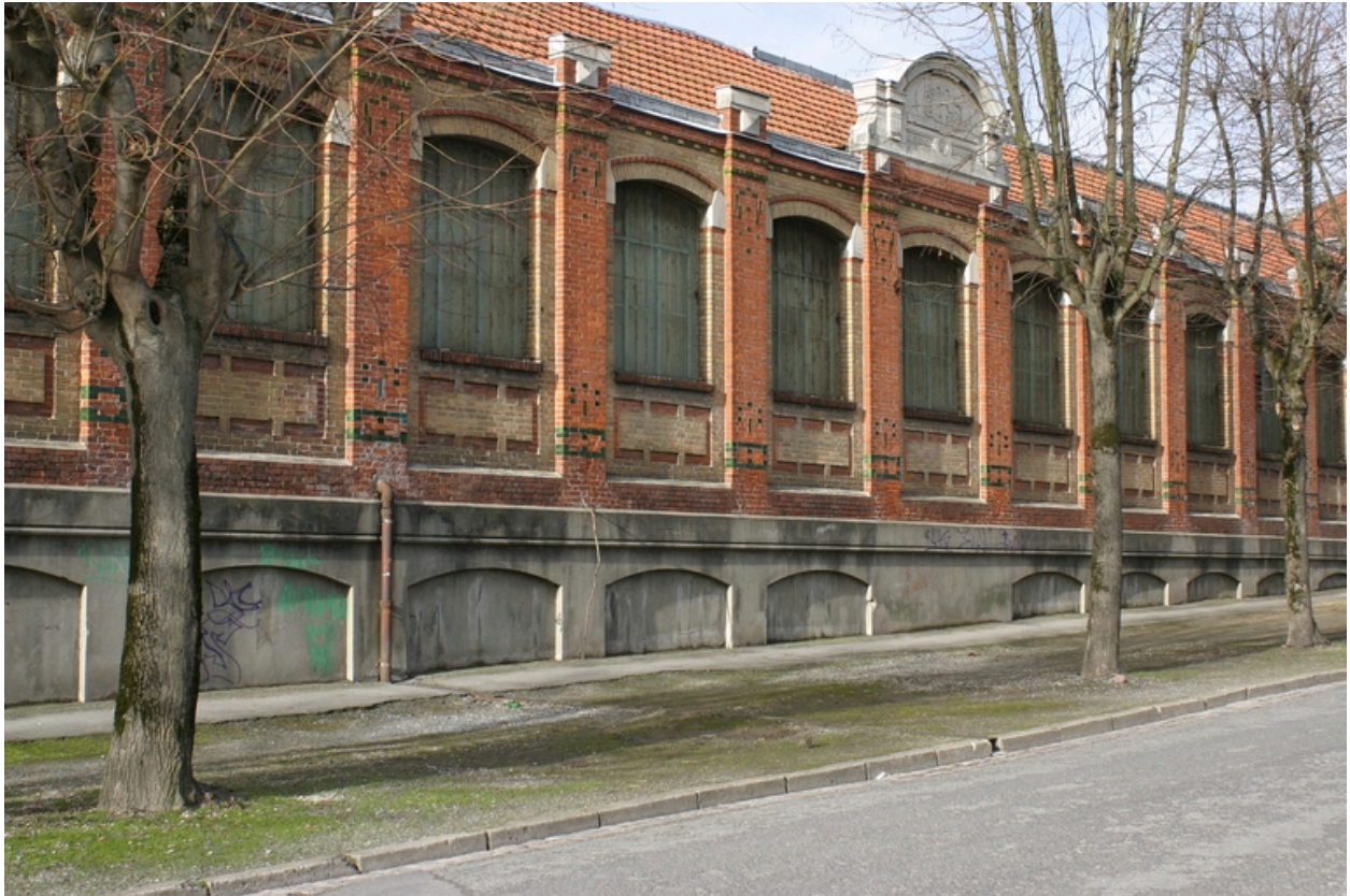
Façade des ateliers : détail.
