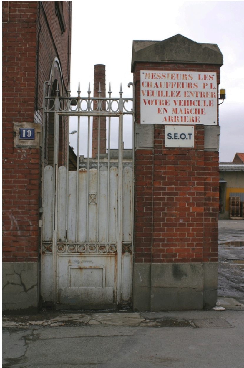
Porte piétonne et cheminée d'usine.
