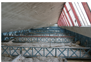
Vue de la structure des sheds, au-dessus des ateliers. Phot. Frédéric Pillet IVR22_20060205093NUCA
