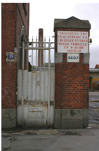
Porte piétonne et cheminée d'usine.
