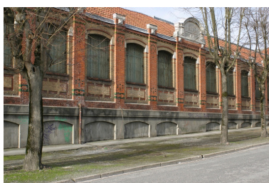
Façade des ateliers : détail. Phot. Frédéric Pillet IVR22_20060205046NUCA
