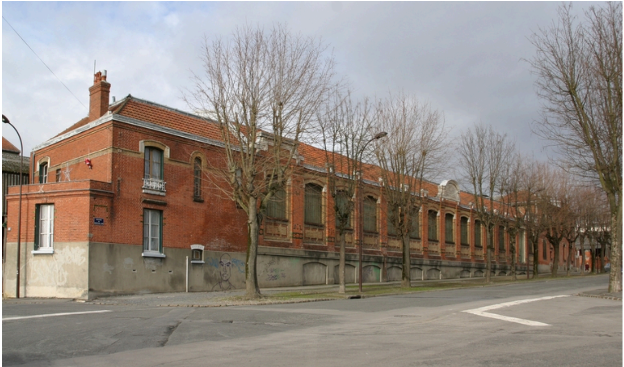
Logement de contremaître et façade des ateliers.
