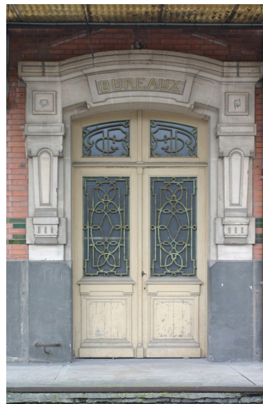
Entrée des bureaux. Phot. Frédéric Pillet IVR22_20060205044NUCA
